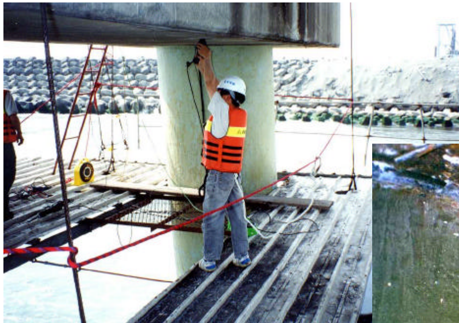
混凝土剝落層與 個別金屬元件鑿除
