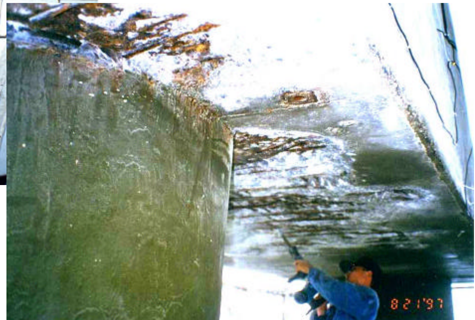
混凝土剝落層與 個別金屬元件鑿除
