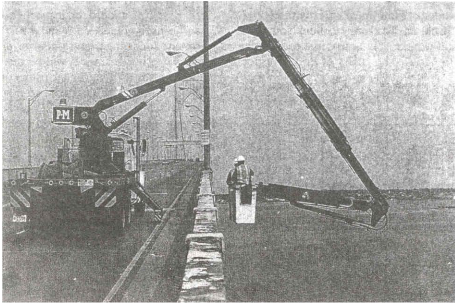
圖 2.8 橋梁檢測時所用之典型多吊臂桿車
