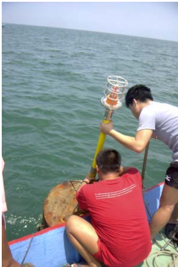
圖 1.14 安平五站更換浮燈
