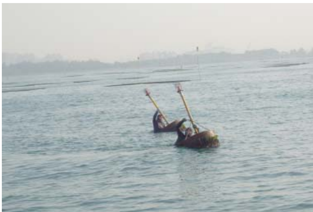
圖 1.13 安平五站由潛水人員更換浮燈
