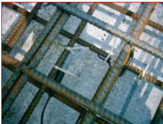
照片二一 參考電極及工作電極安裝
