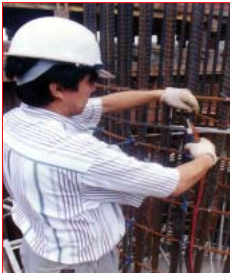
照片十七 鈦條焊接
