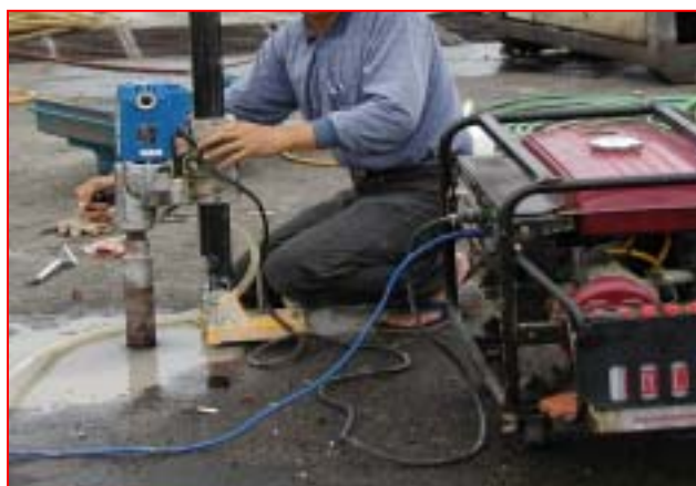
照片八 鑽心取樣照片
