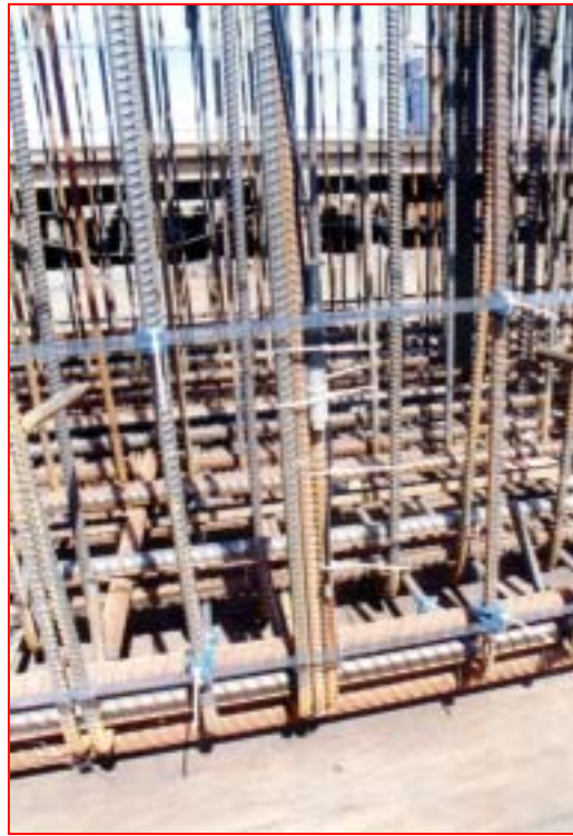
照片十六 參考電極及工作電極安裝
