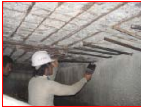
照片十一 鋼筋重新植筋
