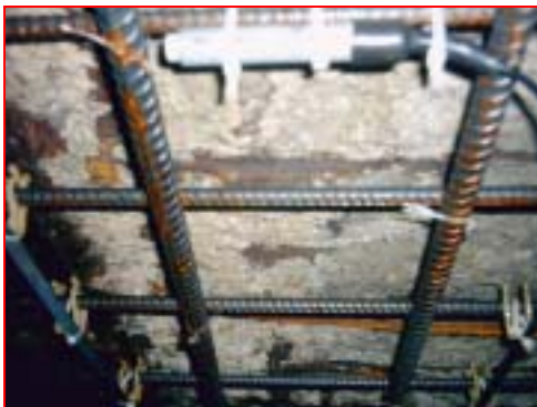
照片十二 鋼筋植筋原設計鋼筋回復
