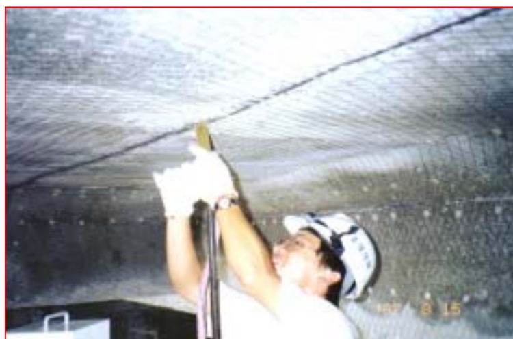
照片二 陽極安裝
