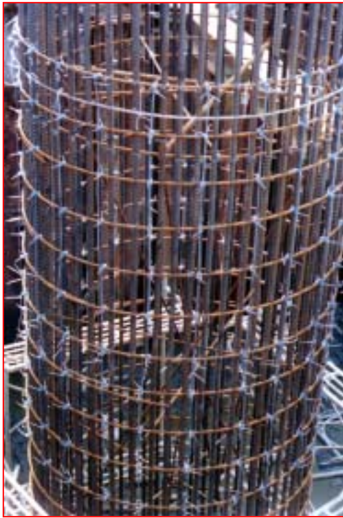
照片十五 帶狀鈦網以鋼筋固定夾安裝
