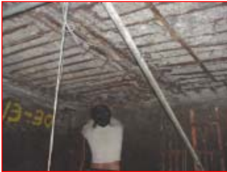
照片十 混凝土鑿除
