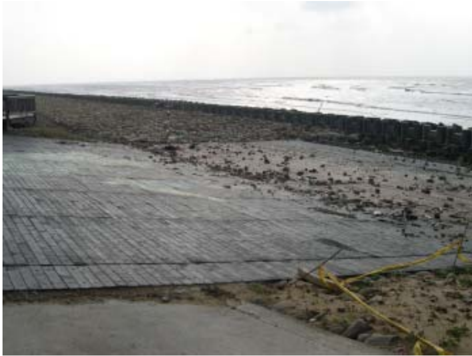
照片 10-2 風帆船之斜坡道 2
