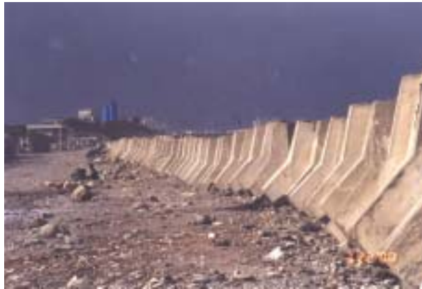
照片 6-8 化仁海岸消波塊照片
