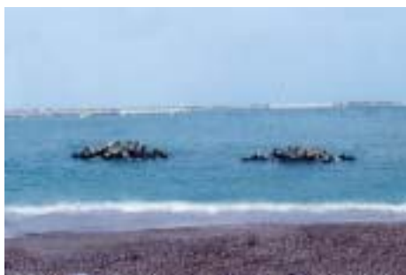
照片 6-19 離岸堤 A
