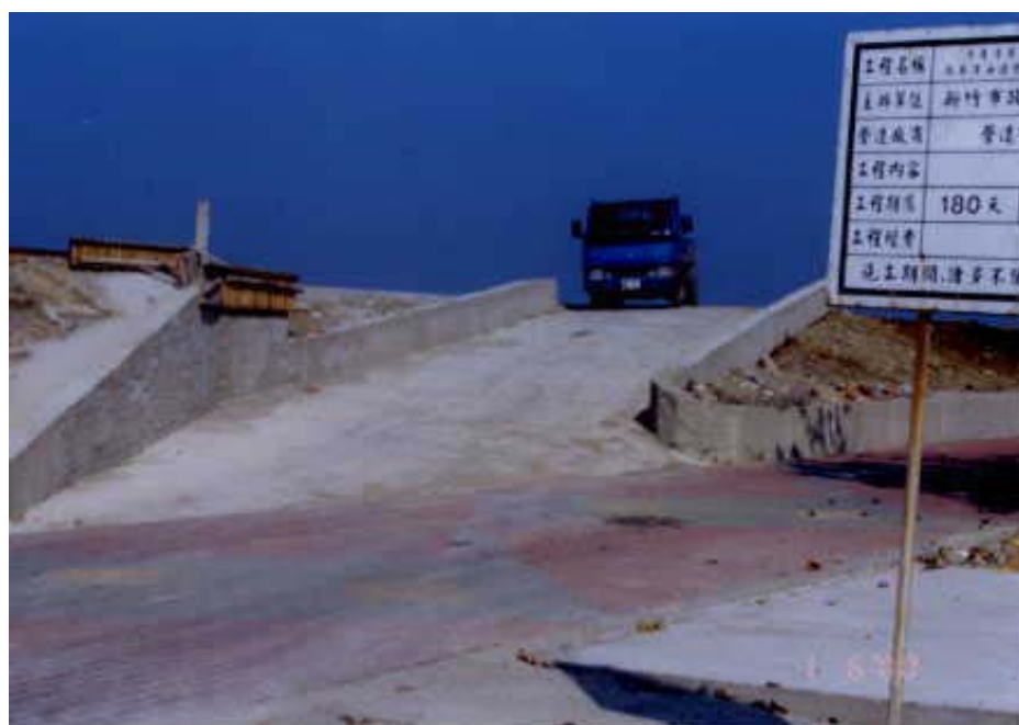
照片 10-1 風帆船之斜坡道 1
