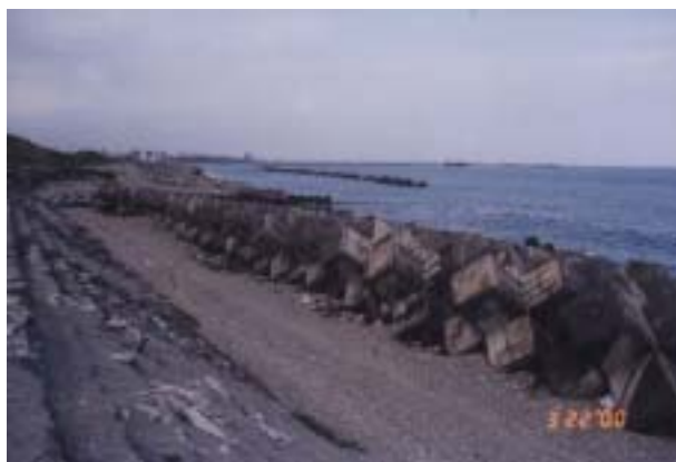
照片 6-9 化仁海堤照片
