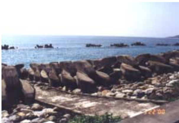
照片 6-4 南濱海堤之緩坡側
