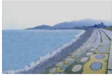
照片 6-24 緩坡海堤
