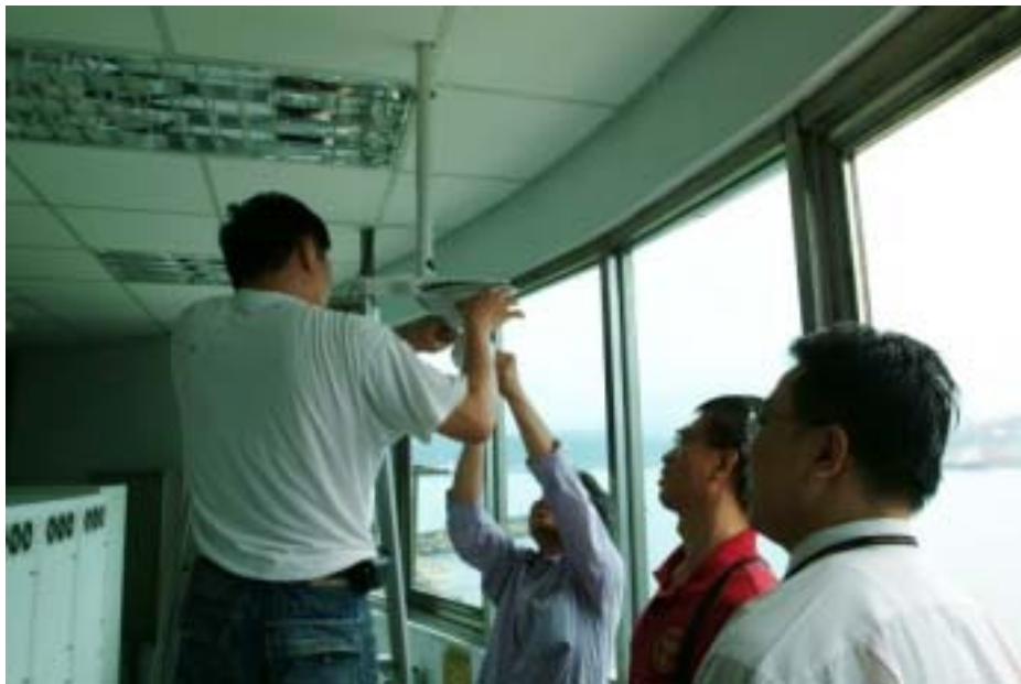
圖 49 基隆港攝影機裝置情形
