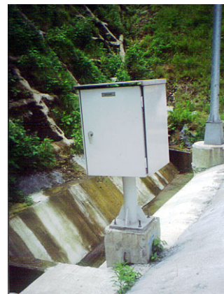
圖 3.1.3-1 埋設於高速公路路面之環路線圈(左)／路側之車輛偵測器之終端控制器(右)
