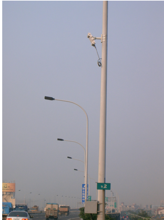
圖 6.4-1 VD 設置圖
