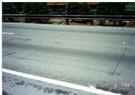
圖 3.1.3-1 埋設於高速公路路面之環路線圈(左)／路側之車輛偵測器之終端控制器(右)
