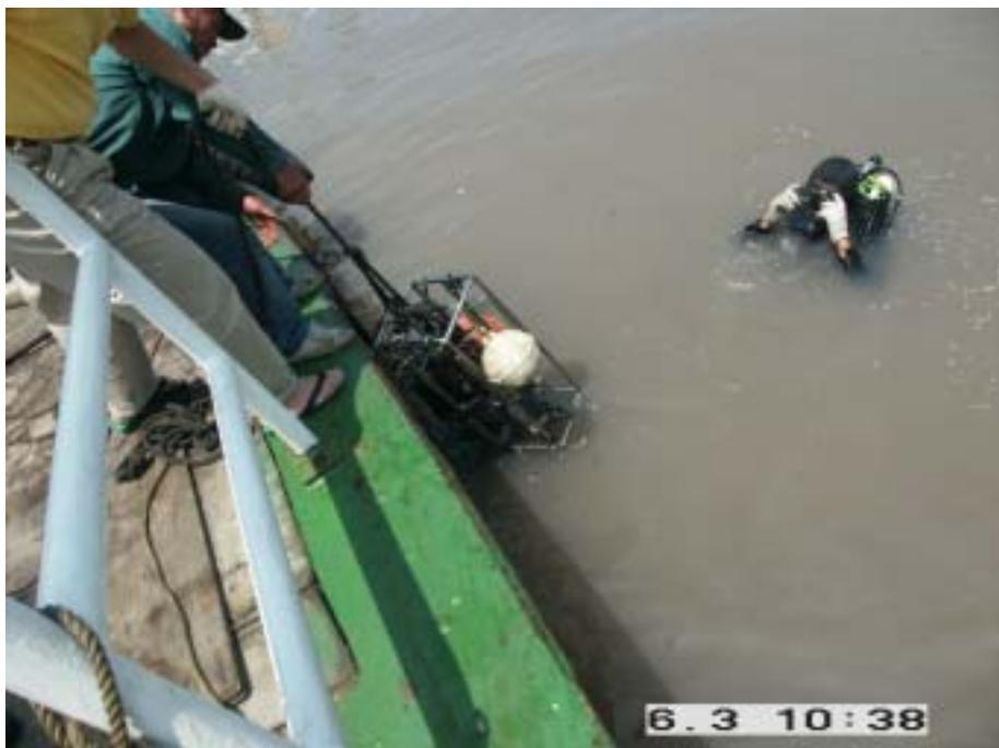
照片 3.6 前鎮河口觀測站潛水人員在污水中安裝儀器情形
