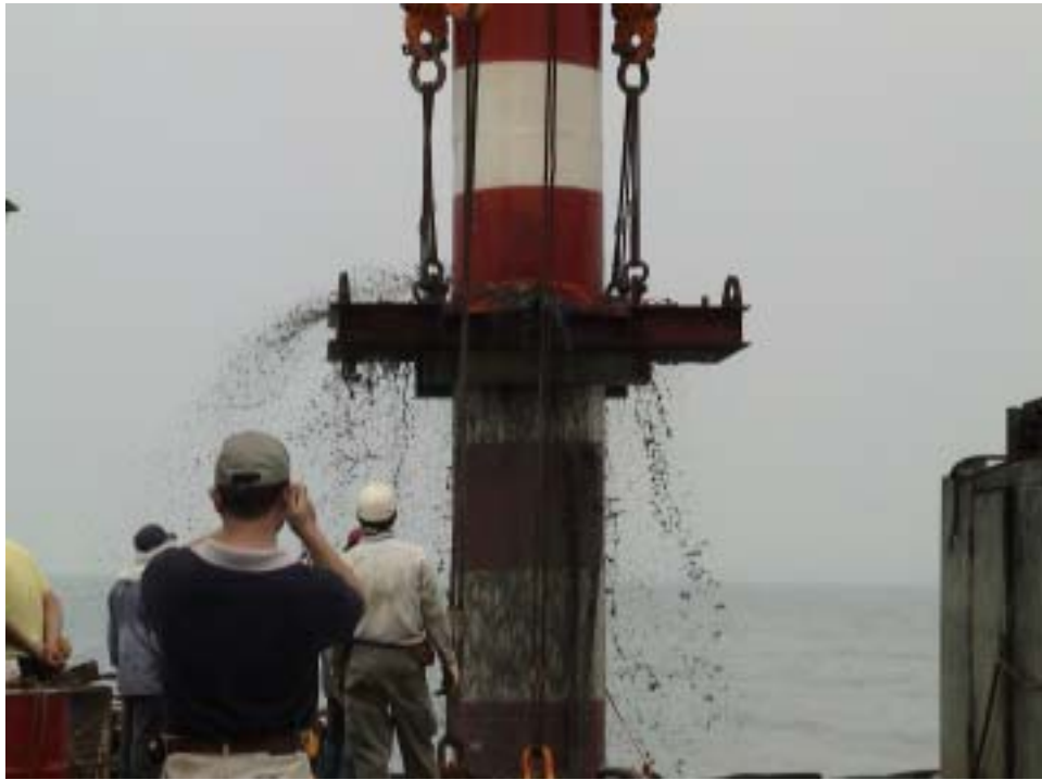
照片 2.1 主樁體下部結構海上打設實景(93/11/02)
