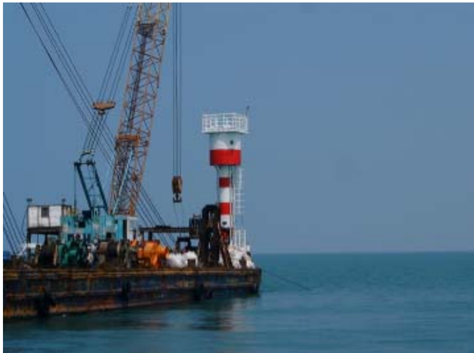
照片 2.2 主樁體上部結構海上打設實景(93/11/03)
