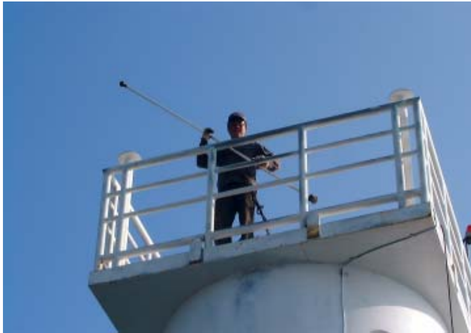
照片 2.5 平台附屬設備安裝實景(93/11/05)
