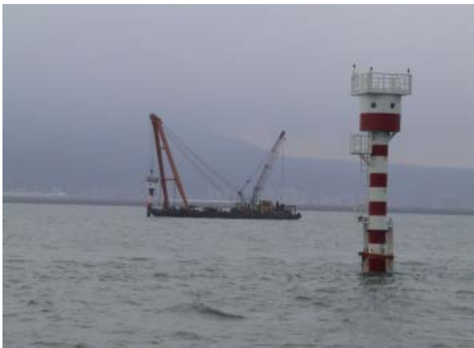
照片 2.8 觀測樁打設完成全景(93/11/06)
