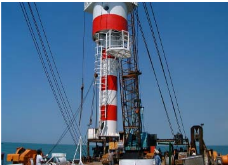
照片 2.3 主樁體下部結構與上部平台接合實景(93/11/03)
