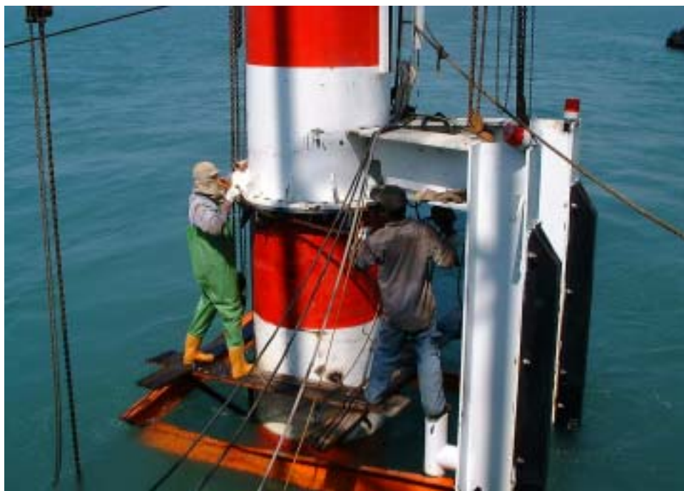
照片 2.4 樁體附屬設備安裝實景(93/11/03)
