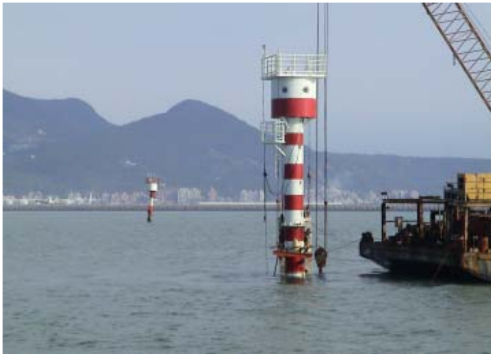
照片 2.7 樁體施工完成實景(93/11/05)
