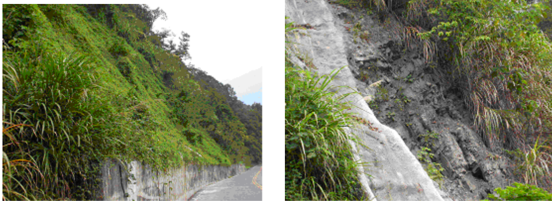
圖 7.27 台 21 線 109k+500 900 路段坡面保護現況
