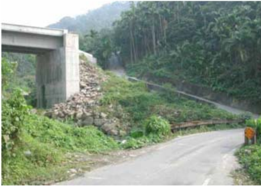
圖 6.4 道路改線採架橋方式通過野溪
