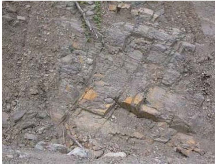
圖 7.31 台 21 線 111k+00 112k+200 路段邊坡傾角走向
