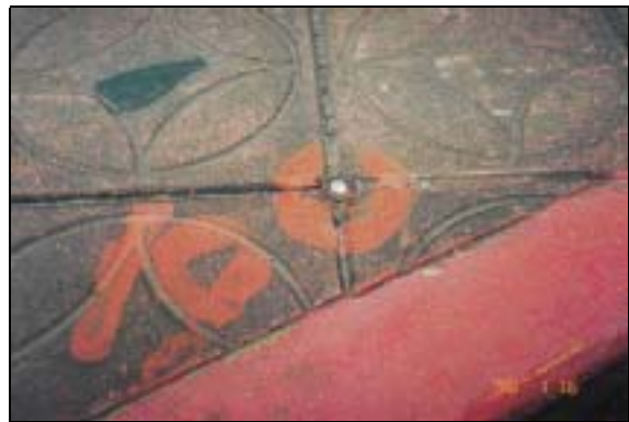
圖 5.16 地表沈陷觀測點完成照片
