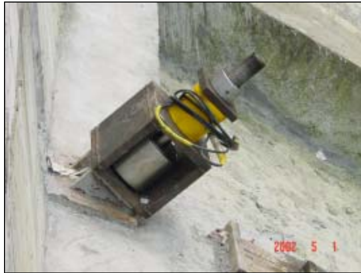
圖 5.27 地錨荷重計安裝完成照片
