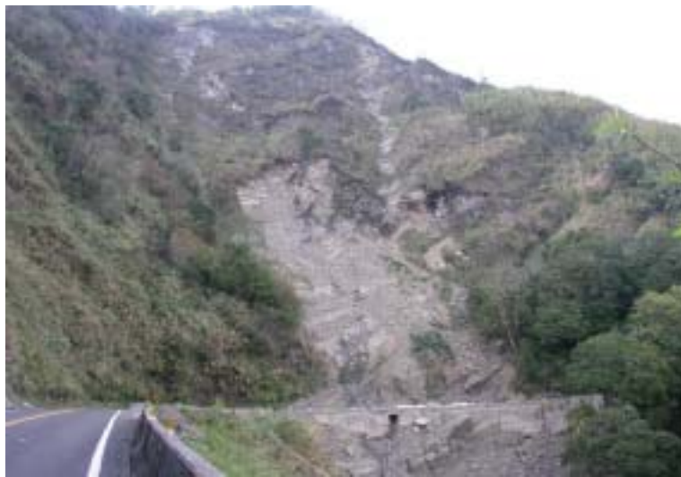
圖 4.17 台 18 線 58k+100 處上邊坡照片
