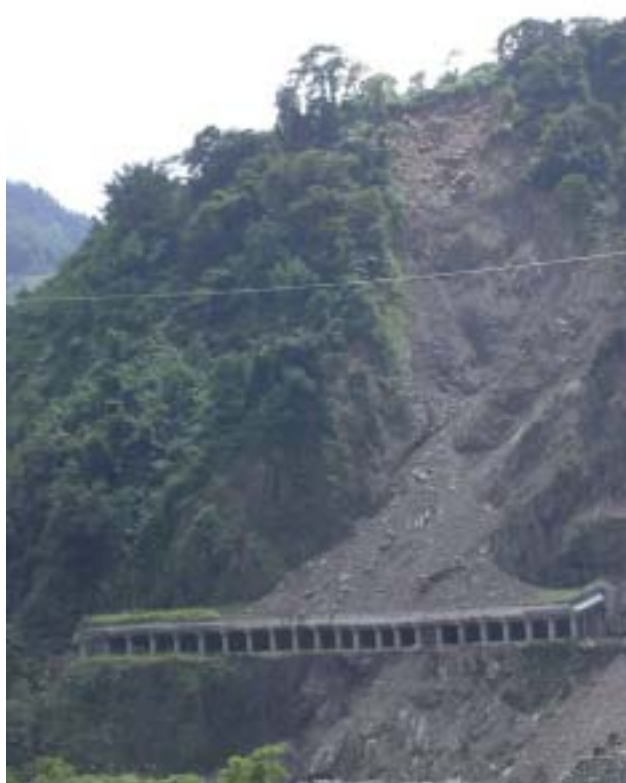
圖 4.19 台 21 線 111k+500 處上邊坡照片
