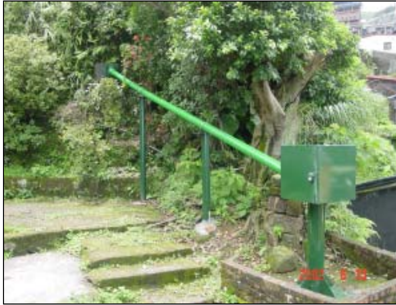
圖 5.13 地滑計（地表伸縮儀）裝設完成照片
