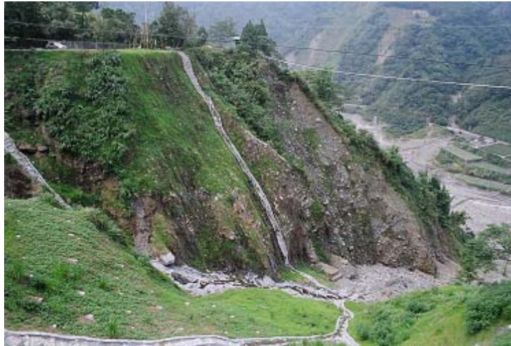
圖 7.40 溪溝堆積材料受溪谷向源侵蝕影響目前有部分岩盤出露
