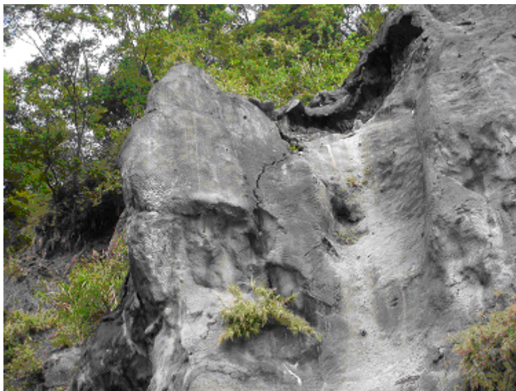
圖 7.34 113k+500 處之大型浮石與裂縫
