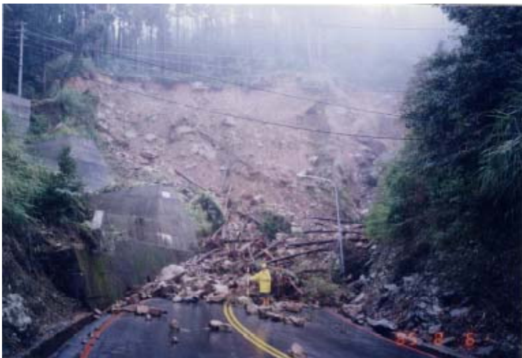
圖 7.6 坍滑示意圖（台 18 線 75K+320 賀伯颱風災害照片）
