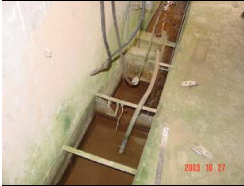
圖 5.5 90° V 型水堰裝設完成照片
