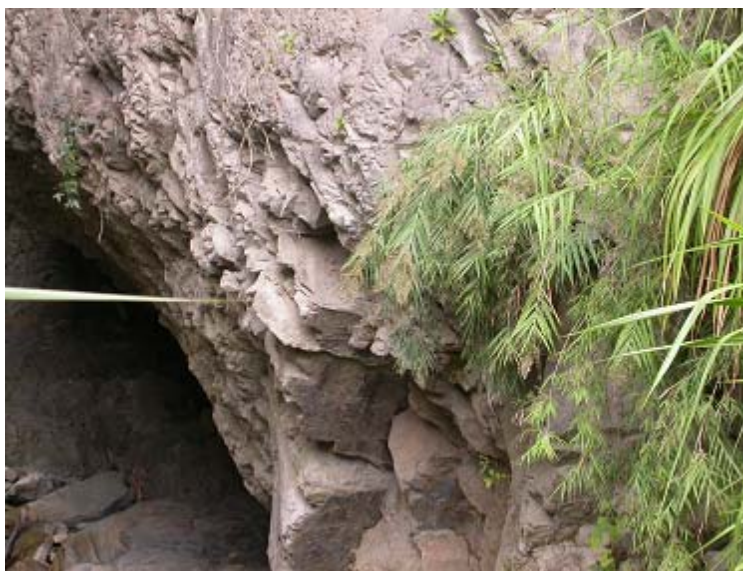
圖 7.26 台 21 線 109k+500 900 路段節理面位態
