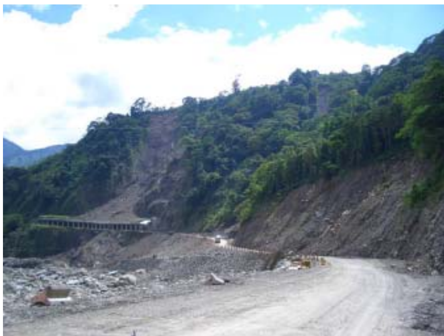
圖 4.20 台 21 線 111k+500 處邊坡照片
