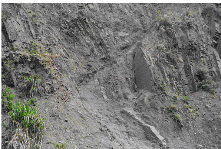
圖 7.35 邊坡出露之岩盤與斷層面
