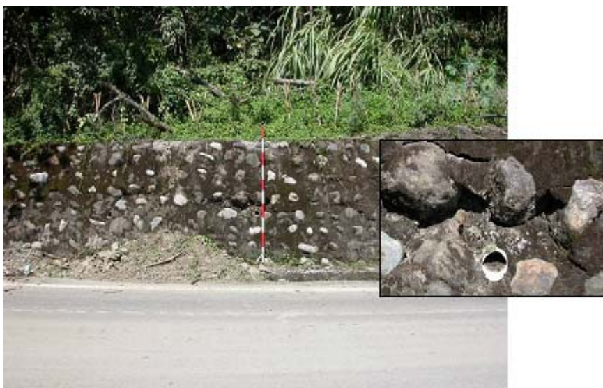
圖 7.54 牆面有明顯裂縫（台 21 線 106k+850 942）
