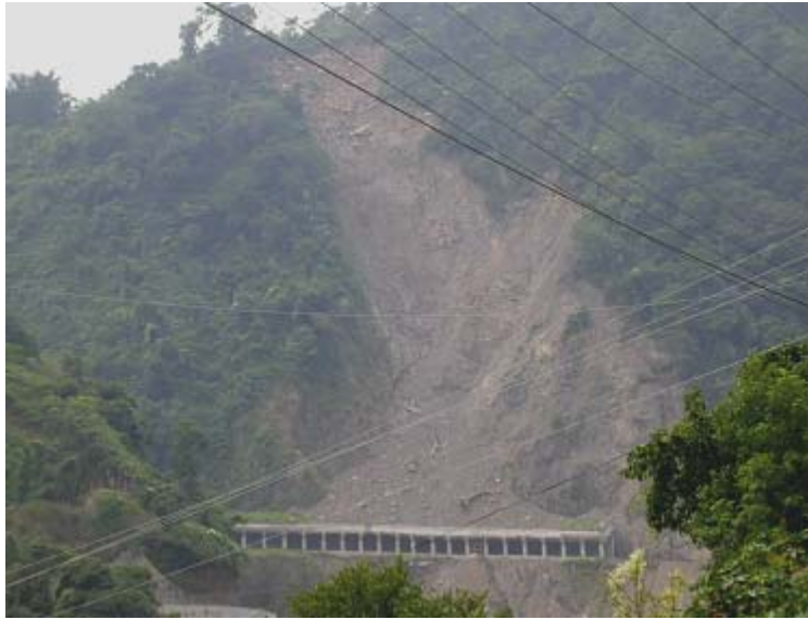
圖 7.33 神木明隧道上方崩塌土體荷重對明隧道結構體之影響
