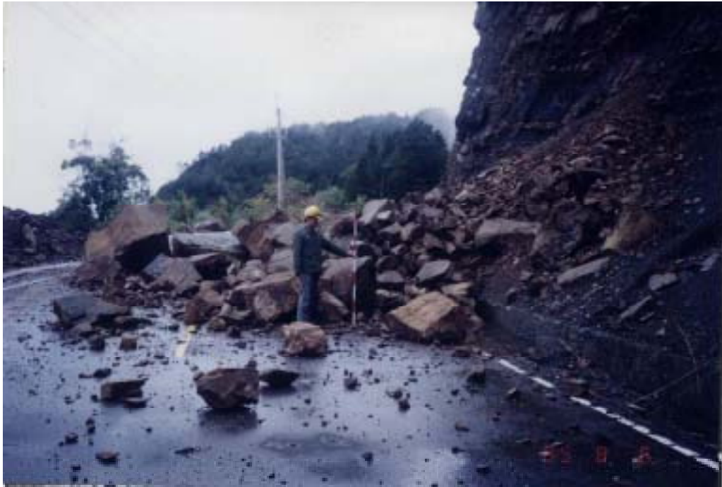
圖 7.5 崩落示意圖（台 18 線 77K+900 賀伯颱風災害照片）
