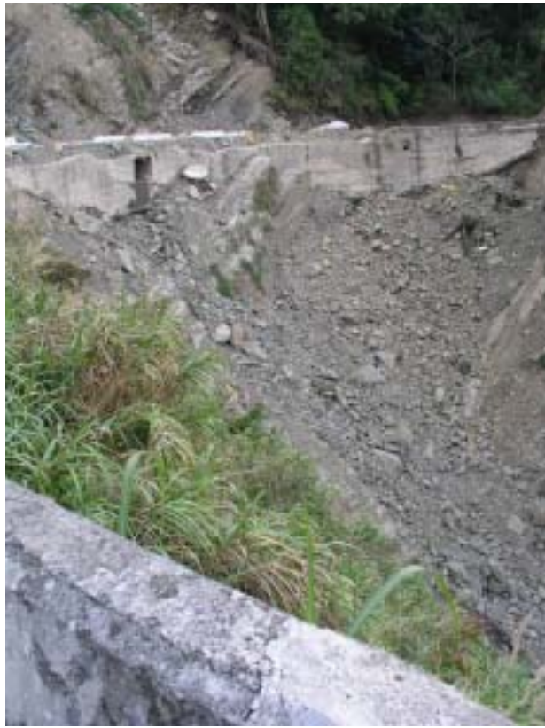
圖 4.18 台 18 線 58k+100 處下邊坡照片
