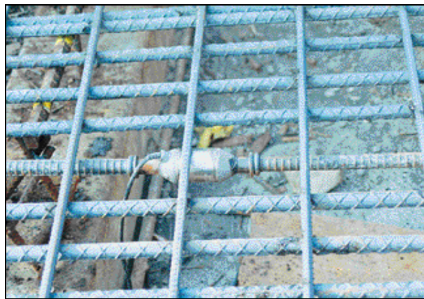
圖 5.25 鋼筋計安裝完成照片
