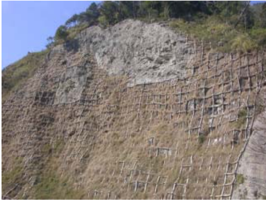
圖 4.12 台 18 線 65k+000 處上邊坡照片
