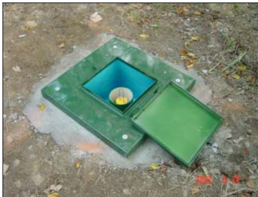
圖 5.8 傾斜觀測管安裝完成
