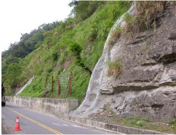
圖 7.22 台 21 線 107k+900 路段坡面噴漿與自由格梁坡面保護現況
