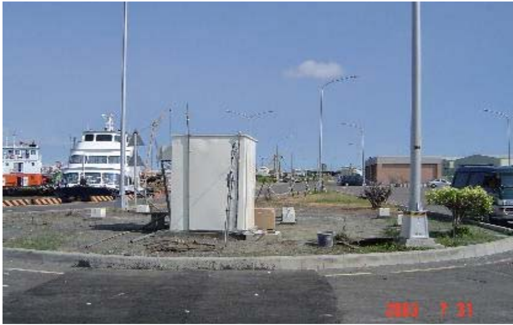
12-15 高雄區地震分層監測站設置完成外貌狀況
