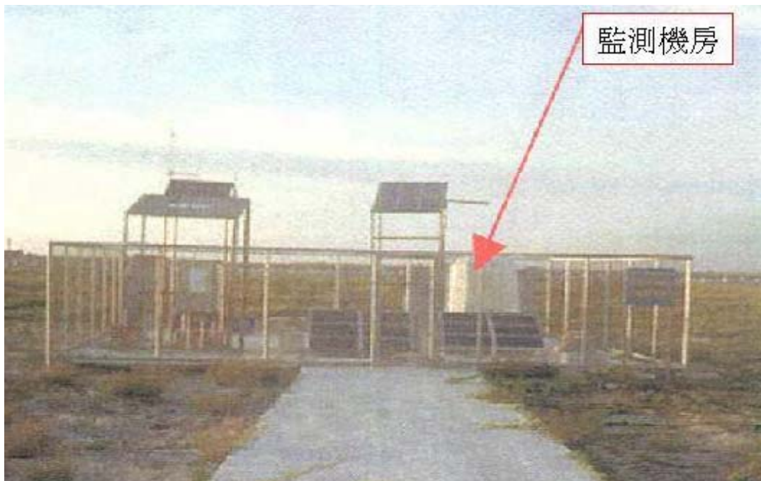
圖 12-11 布袋港區地震分層監測站設置完成外貌狀況
