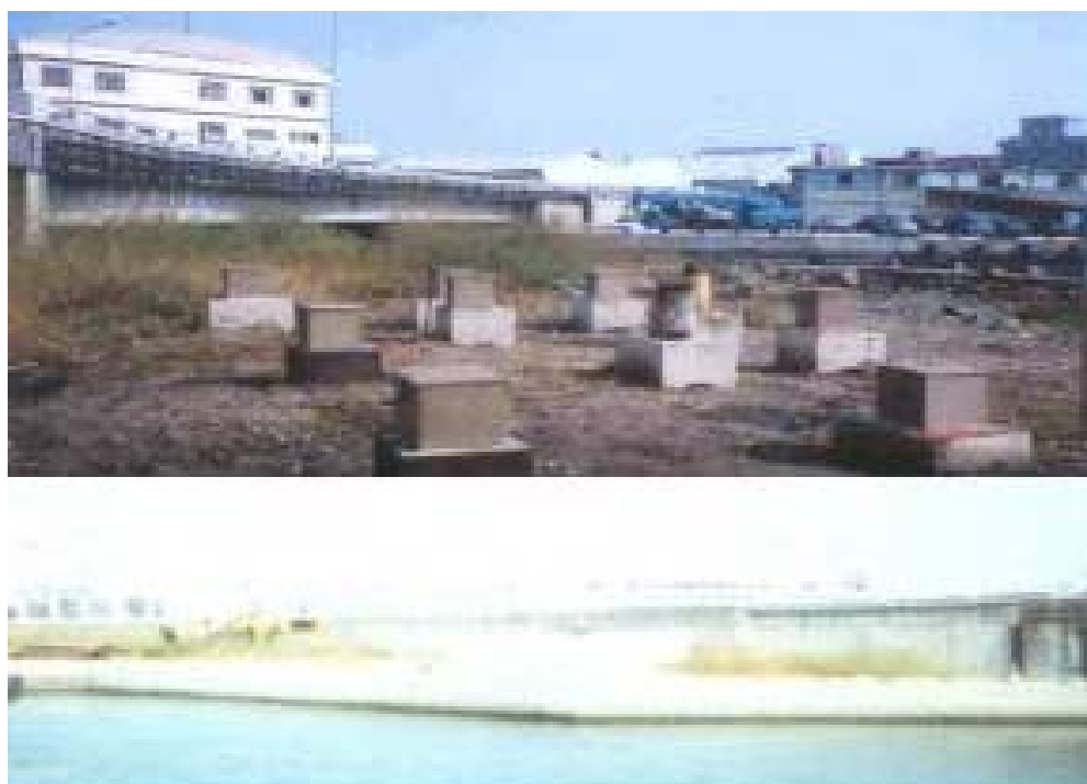
圖 12-8 安平港區地震分層監測站設置完成外貌狀況
