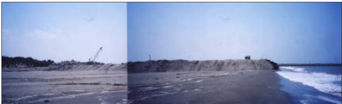
照片 3-15 安平海岸直接置砂法
