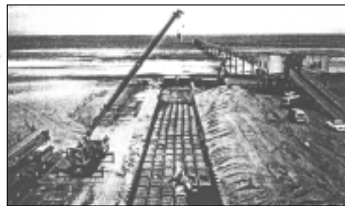
照片 3-13 日本波崎海岸重力排水施工
