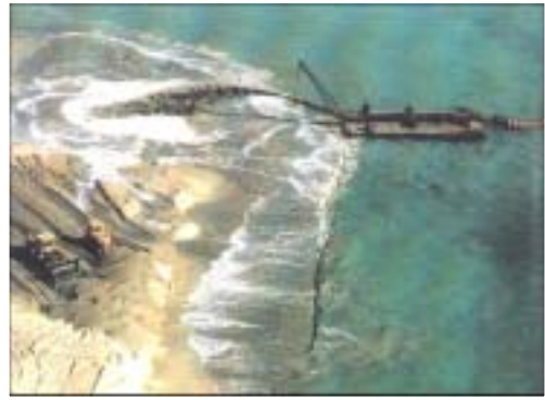
照片 3-14 土砂側渡法施工情形
