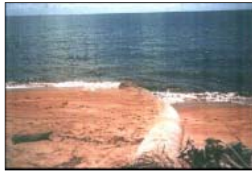
照片 3-11 澳洲飛魚岬海岸地工砂管
