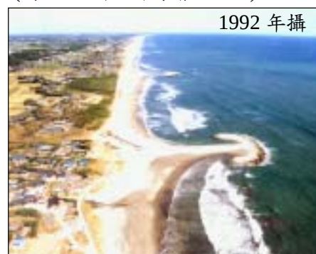
照片 3-28 鹿島灘防治侵蝕實施後
