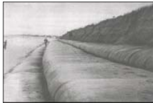
圖 3-8 地工砂管應用於海岸保護 照片 3-12 德國 Isle of Sylt 海岸地工砂管
