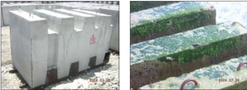
照片 5-5 烏石與富基漁港設計採用之生態型方塊
