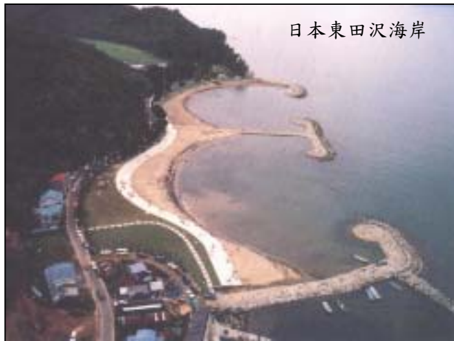
(A)結合離岸堤、岬頭及人工養灘 (B)結合 T 型突堤、緩傾斜護岸及人工養灘
