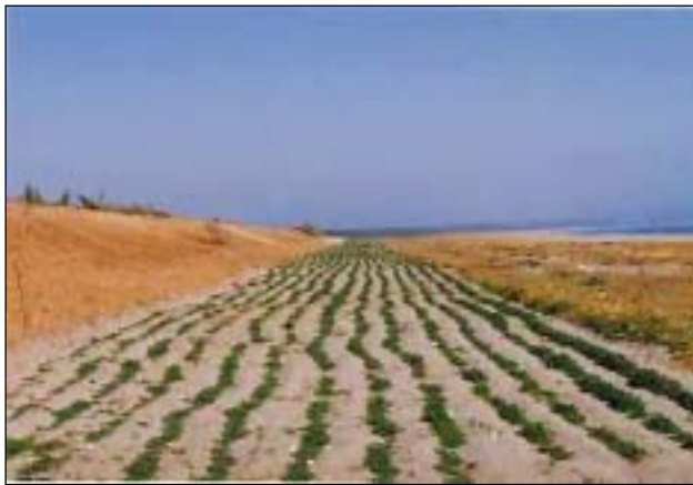
照片 3-17 砂籬與植栽定砂例
