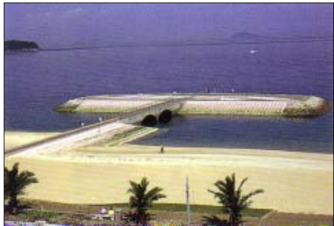
照片 3-25 片添浜海岸拱橋連接之突堤
