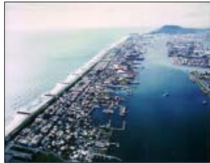
照片 3-4 旗津海岸突堤群
