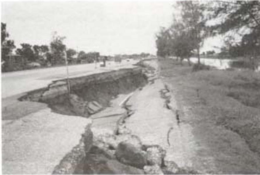
**照片 9.1 路基軟弱土壤剪力強度不足所引致之路堤邊坡滑動照**
