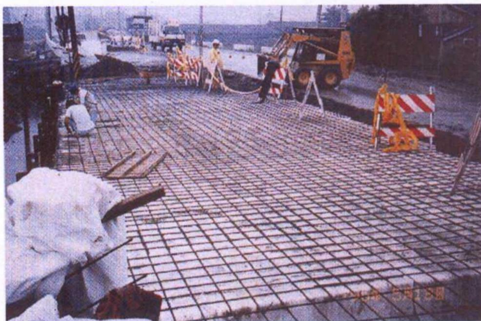
照片 8.5 頂部 10cm 厚 RC 版之鋼筋組立與混凝土澆置照
