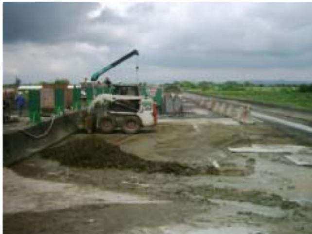
照片 8.2 小型推土機清理水泥漿液照
