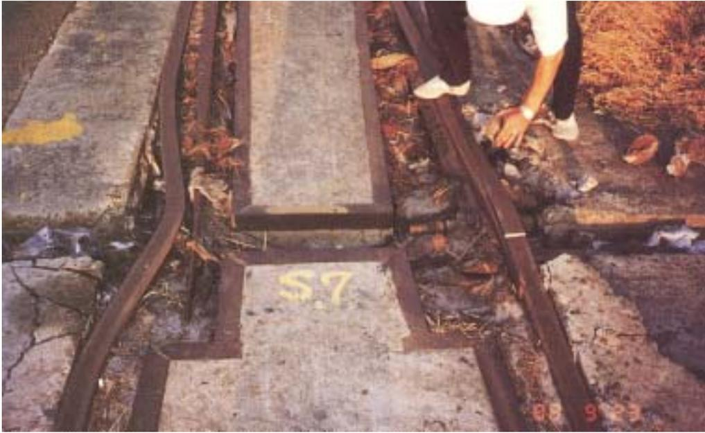
照片 8.9 5~8 號碼頭岔尖處基本鋼軌挫曲照
