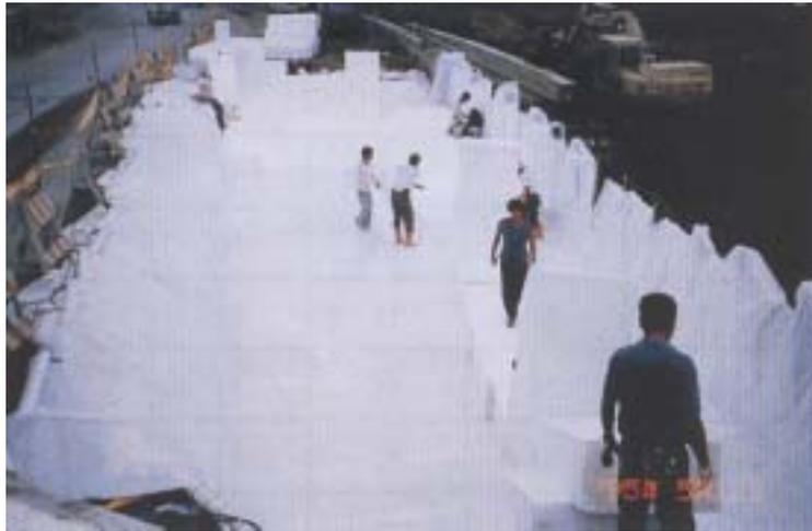
照片 8.6 RC 底版上方及路堤側面鋪設不織布、PE 布及 EPS 塊體照
