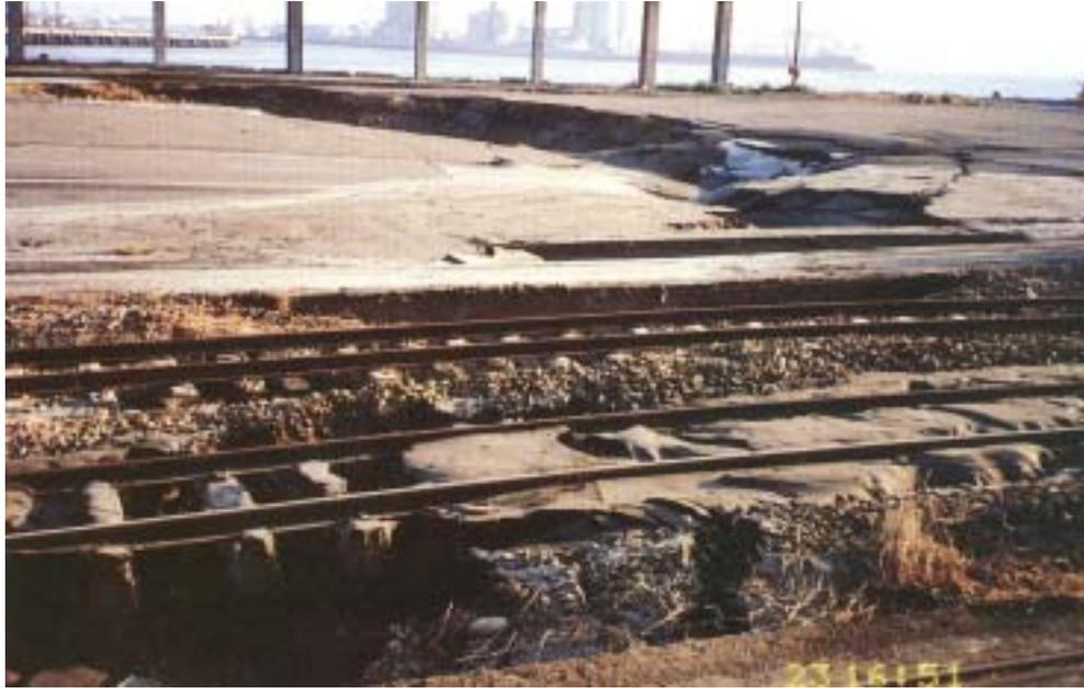
照片 8.7 1~4 號碼頭地盤下陷軌道懸空、扭曲變形照
