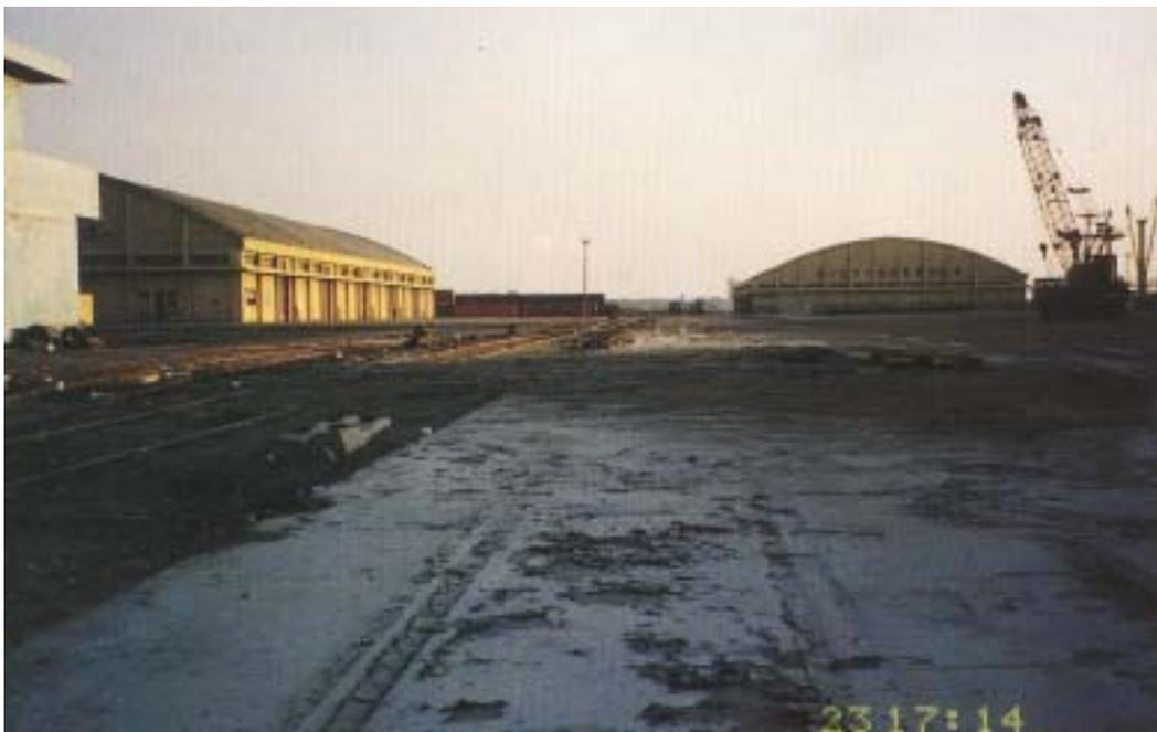
照片 8.10 13 號碼頭湧砂掩埋鋼軌照
