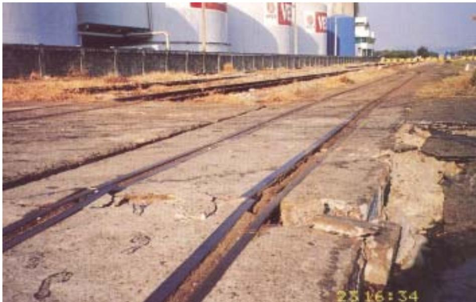
照片 8.8 1~4 號碼頭地盤滑動、擠壓造成鋼軌斷損照
