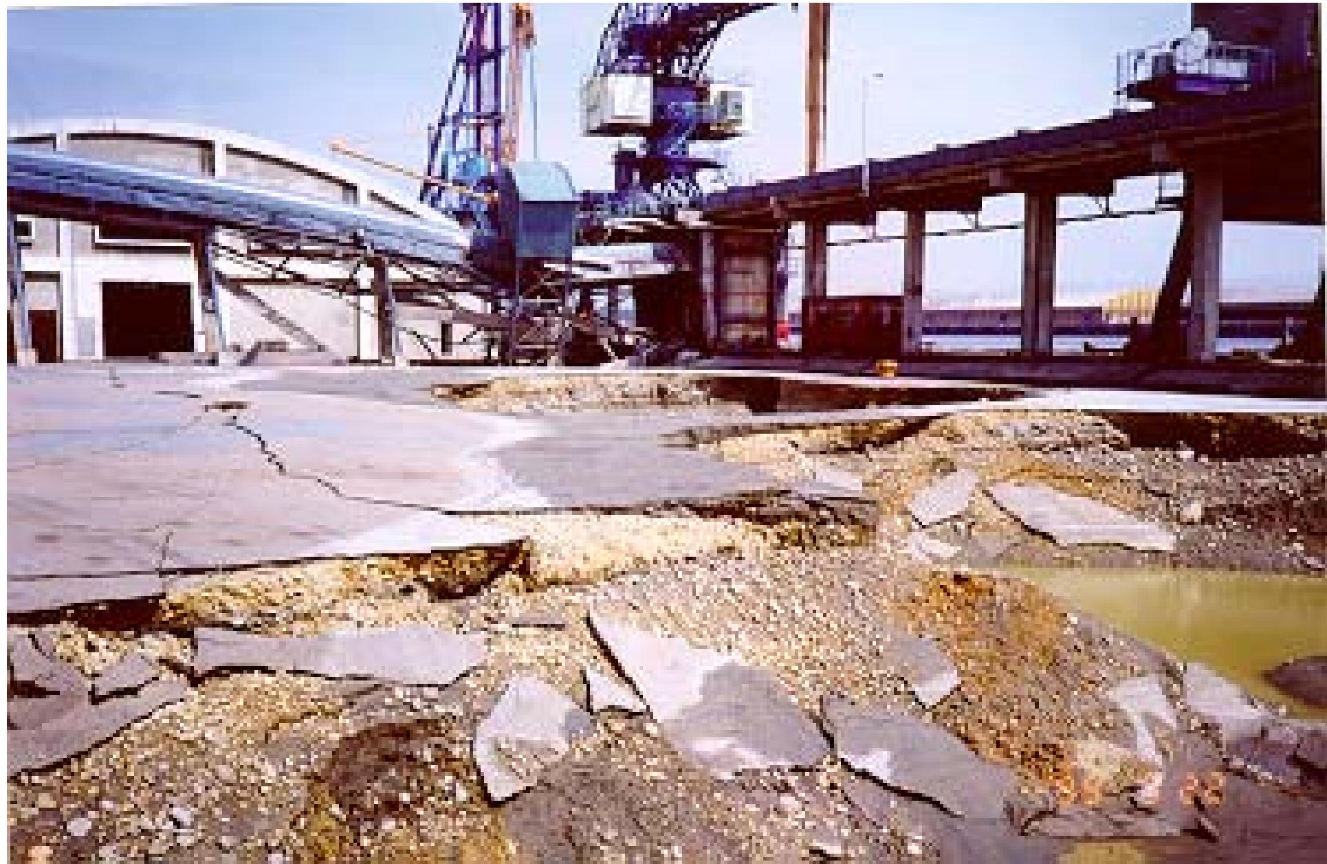
照片3 台中港1號碼頭後線背墳土之砂液化流失，造成
