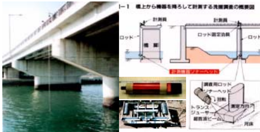
圖 2-22 超音波式河川冲刷監測（日本） [5]
