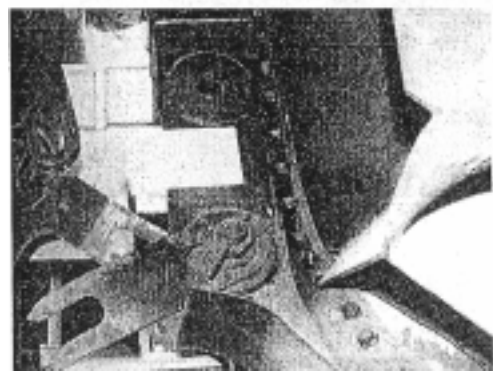
(b)阪神防落裝置破壞斜撐挫屈
