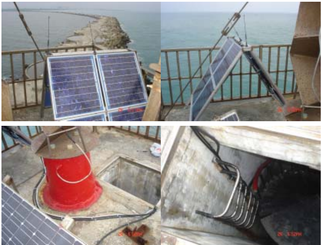
塔頂電源與 GSM 傳輸系統線路安裝：
