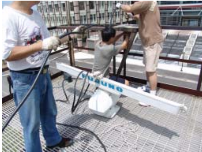
照片 1 拆卸雷達天線部分
