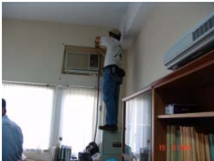
照片 10 進行纜線安裝工作
