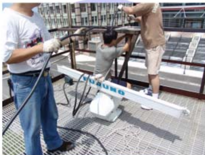
圖一、拆卸雷達天線部分
