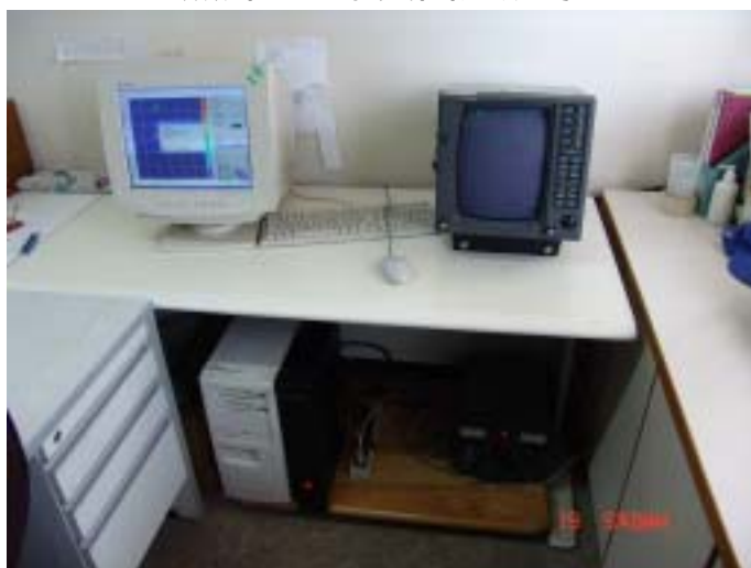
照片 14 完成系統安裝
