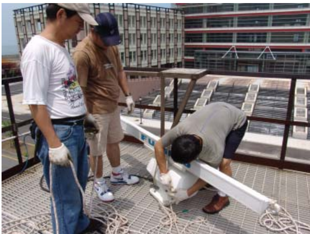
照片 17 台北港雷達搬遷作業
