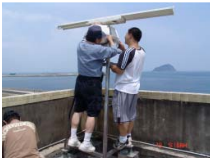
照片 9 海洋大學進行雷達支架與天線安裝
