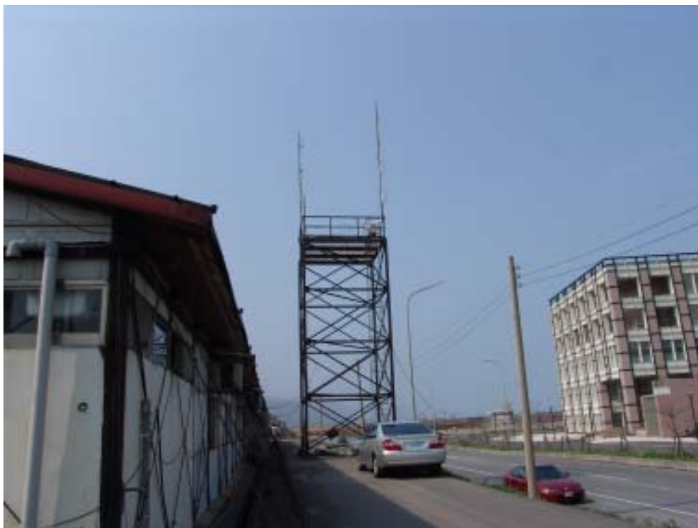
照片 15 台北港雷達安裝平台
