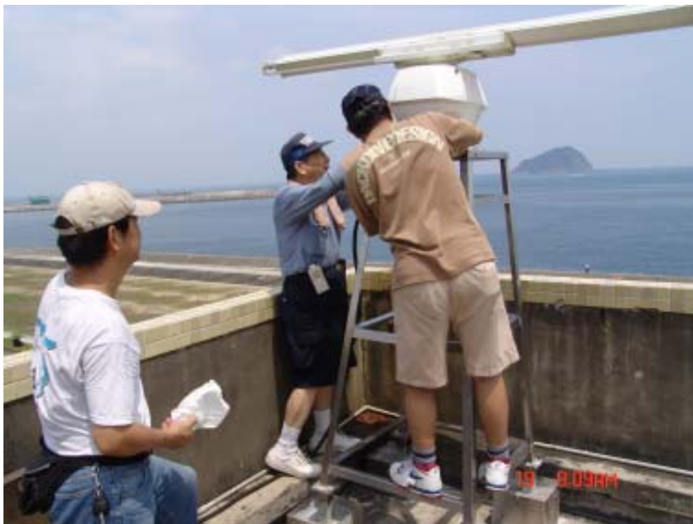
照片 20..海洋大學雷達天線安裝情形
