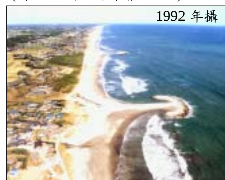
照片 2.28 鹿島灘防治侵蝕實施後
