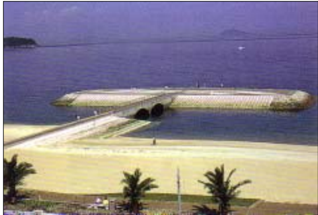
照片 2.25 片添浜海岸拱橋連接之突堤
