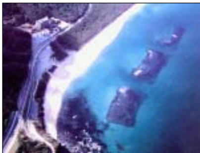
照片 2.7 日本鐘崎海岸人工潛礁
