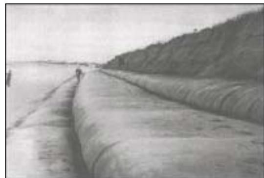
圖 2.8 地工砂管應用於海岸保護 照片 2.12 德國 Isle of Sylt 海岸地工砂管
