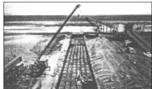
照片 2.13 日本波崎海岸重力排水施工
