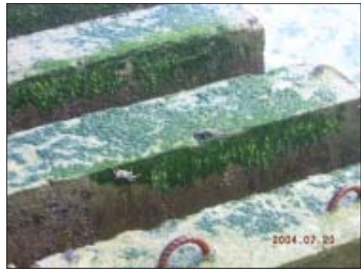
照片 5-5 烏石與富基漁港設計採用之生態型方塊
