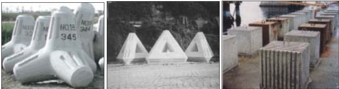
照片 4.2 表面凹凸處理之消波塊與方塊
