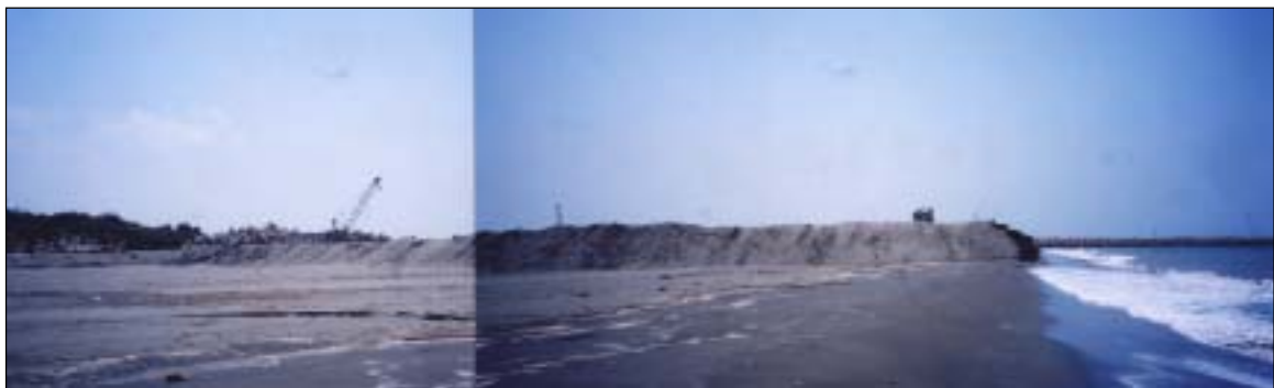
照片 2.15 安平海岸直接置砂法
