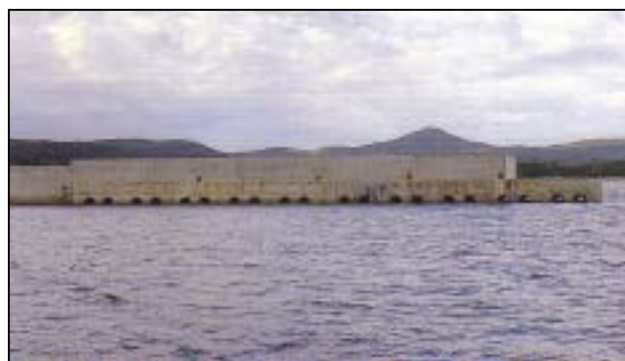
照片 5.4 石川縣富來漁港具海水交換機能之透水堤
