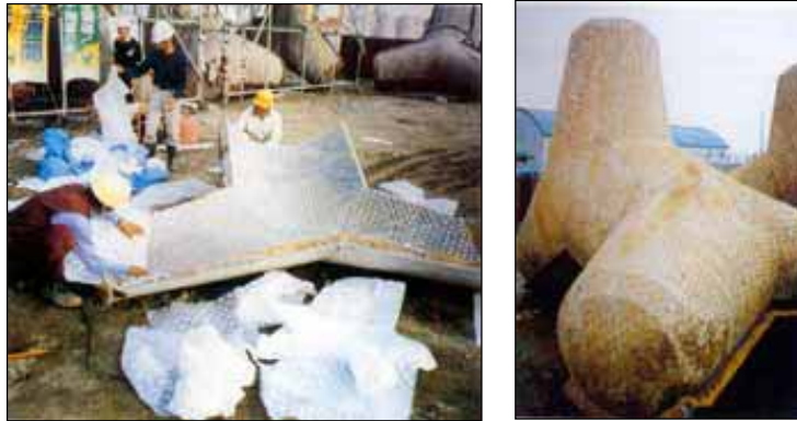
照片 4.3 消波塊表面加設纖維網
