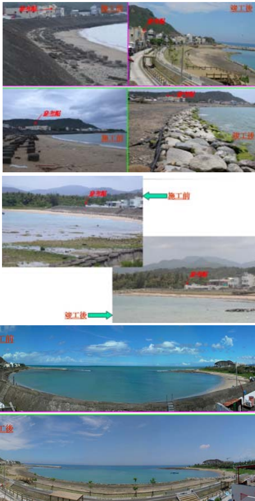
照片 4.4 後灣海岸環境及景觀改善工程施工前後( http://www.wra07.gov.tw )
