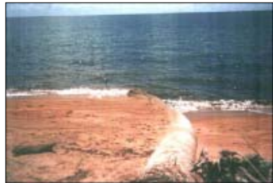
照片 2.11 澳洲飛魚岬海岸地工砂管
