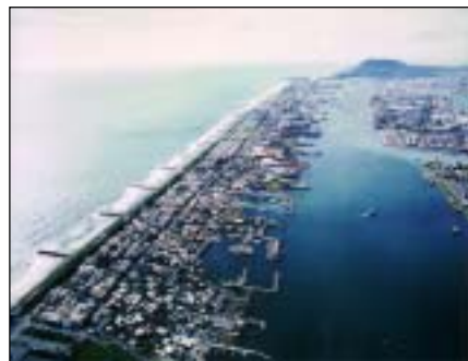
照片 2.4 旗津海岸突堤群
