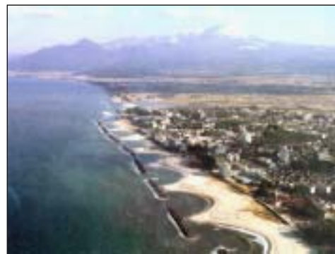
照片 2.6 日本皆生海岸離岸堤群
