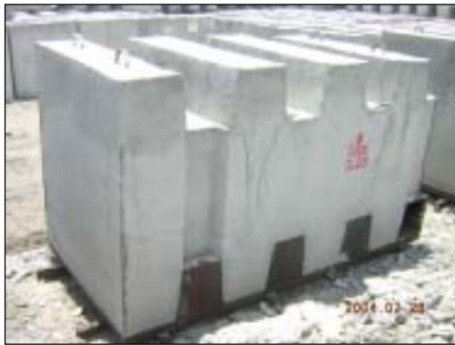
照片 5-5 烏石與富基漁港設計採用之生態型方塊
