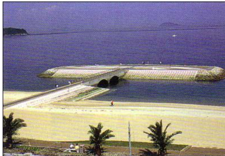
片添浜海岸拱橋連接之突堤
