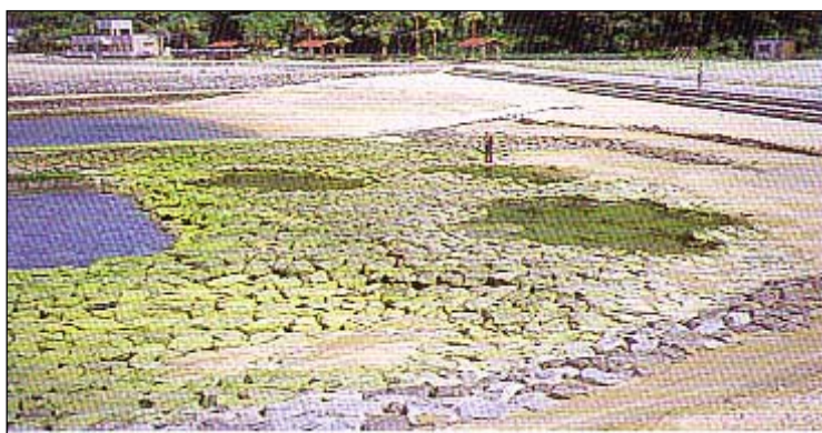
人工潮池施工例
