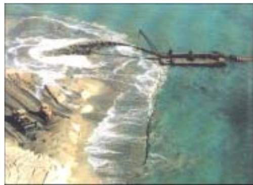
照片 2.14 土砂側渡法施工情形
