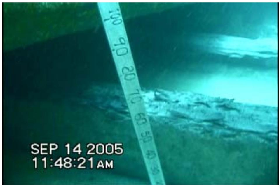
圖 5.2 花蓮港東防波堤#71 沉箱外海側底部掏空情形
