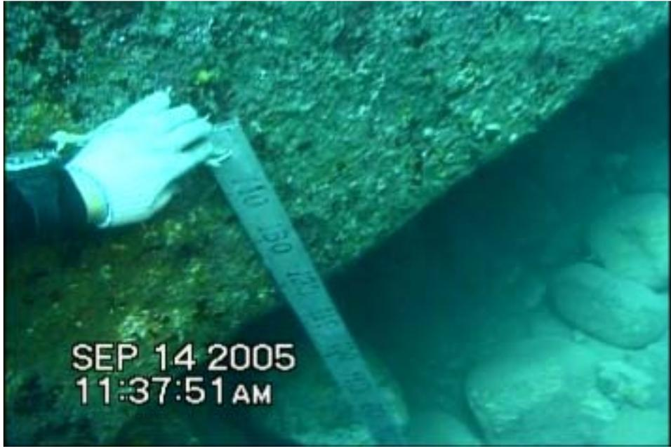
圖 5.1 花蓮港東防波堤#65 沉箱外海側底部掏空情形
