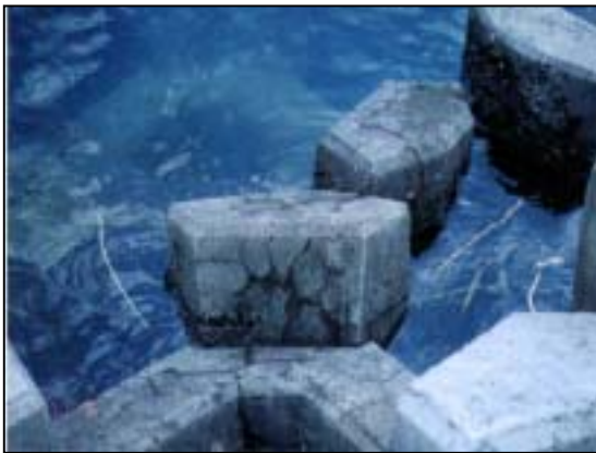
照片 4.13 花蓮港航道消波塊地圖狀裂縫
