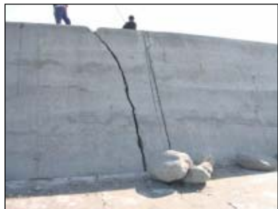
照片 4.14 石梯港消波塊地圖狀裂縫
