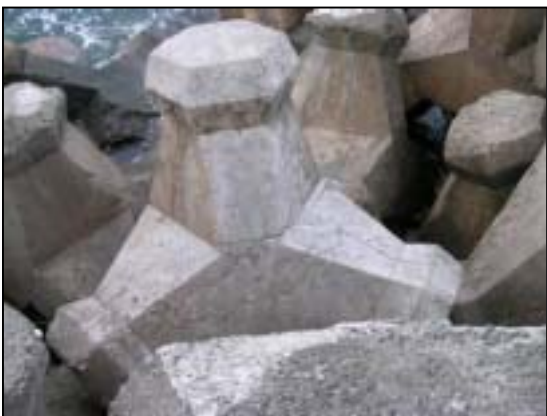
照片 4.13 花蓮港航道消波塊地圖狀裂縫
