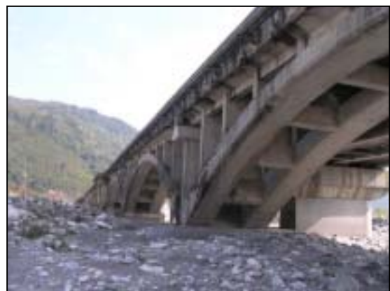
照片 4.11 跨越之臺九線鐵路橋平行主鋼筋方向裂縫
