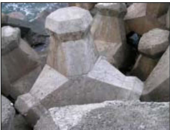
照片 4.4 花蓮港航道消波塊地圖狀裂縫
