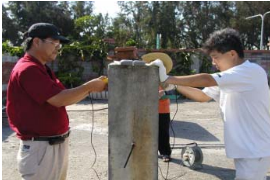
照片 3.2 現地混凝土試驗牆超音波量測
