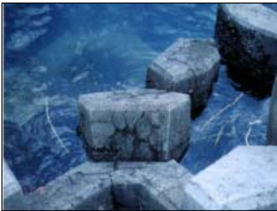
照片 4.4 花蓮港航道消波塊地圖狀裂縫
