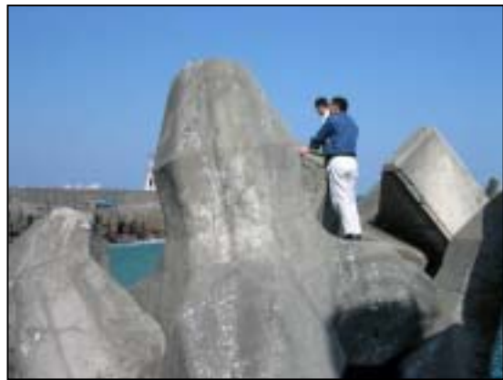
照片 4.5 石梯港消波塊地圖狀裂縫
