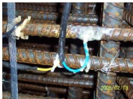
照片 5 工作電極及參考電極引線安
