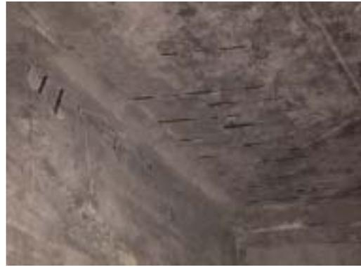
T2-30 橋面版鋼筋腐蝕外露
