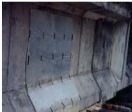
圖 21 鋅膜導電膠<sup>[12]</sup>
