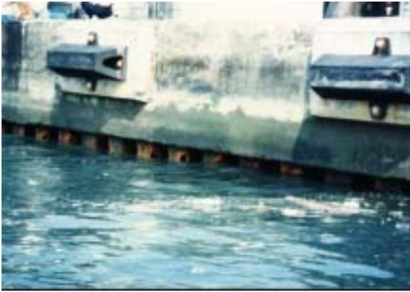
圖 2 鋼板樁穿孔破洞情形(低潮位線)
