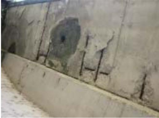
T2-27 橋面版 RC 破裂鋼筋腐蝕外露
