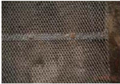
圖 20 犧牲式陰極保護基樁夾層<sup>[12]</sup>
