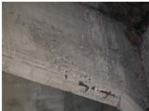
T11-09 間隔梁鋼筋腐蝕外露
