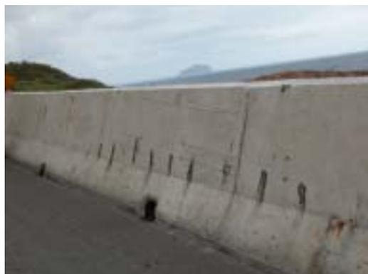
**T2-20 護欄鋼筋腐蝕外露**
