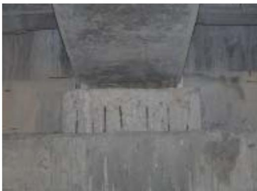
T9-16 支承下方 RC 剝落鋼筋腐蝕外露
