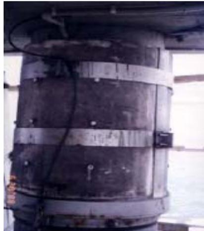
圖 17 外加電流法<sup>[12]</sup>
