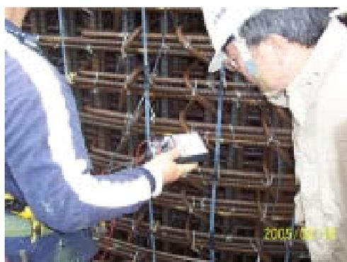
照片 12 組模前工作電極 負極測試
