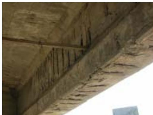
**T2-30 大梁 RC 爆裂鋼筋腐蝕外露**
