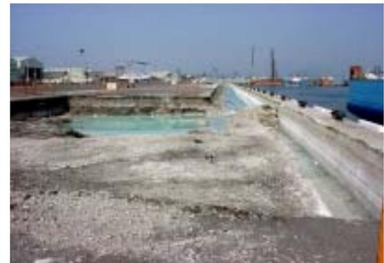
拉桿斷裂，無法承受設計拉力
