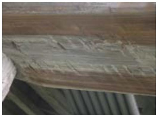
T15-10 帽梁底 RC 爆裂鋼筋腐蝕外露
