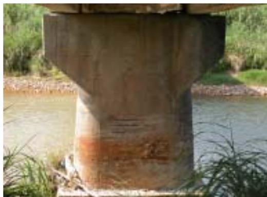
T2-12 橋墩 RC 破裂鋼筋腐蝕外露
