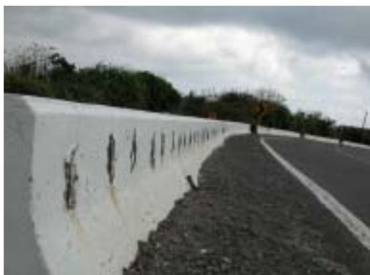
**T26-06 引道鋼筋腐蝕外露**
