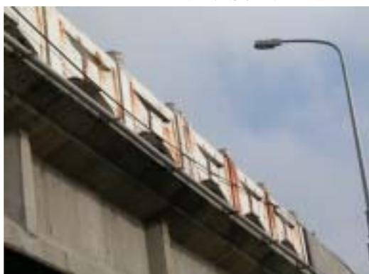
**T2-30 橋護欄損毀鋼筋腐蝕外露**
