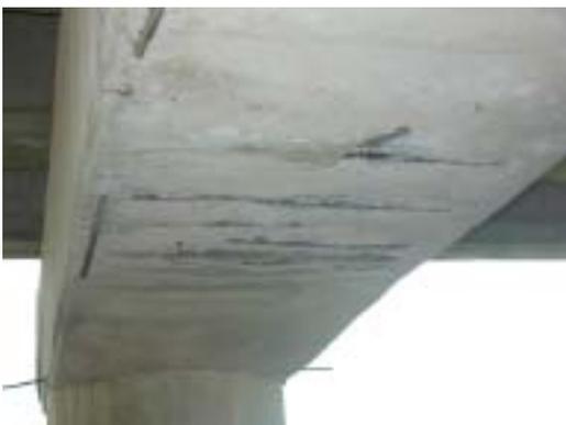
T15-01 帽梁底 RC 爆裂鋼筋腐蝕外露
