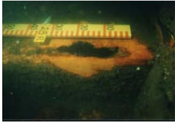
圖 3 鋼板樁穿孔破洞情形 (水中)
