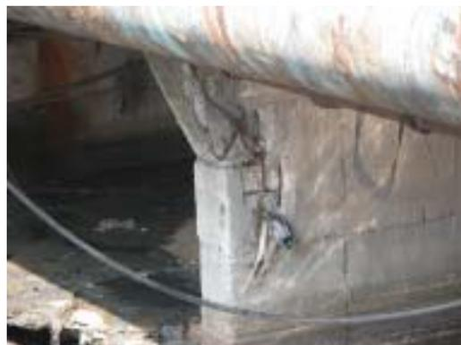
T2-16 橋墩 RC 破裂鋼筋腐蝕外露
