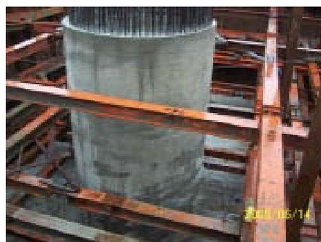
照片 23 混凝土澆置拆模後
