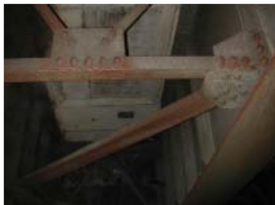
林口高架橋熱浸鍍鋅鋼構銹蝕
