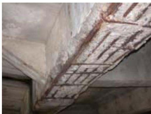
**T2-22 大梁 RC 爆裂鋼筋外露**
