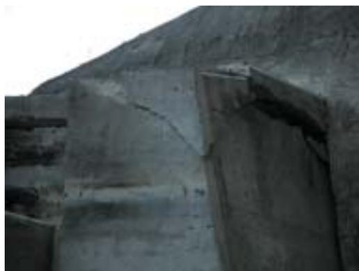
T11-17 橋台 RC 破損
