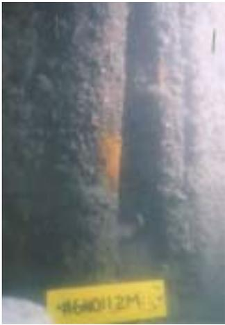
圖 4 鋼板樁海底底床開裂情形
