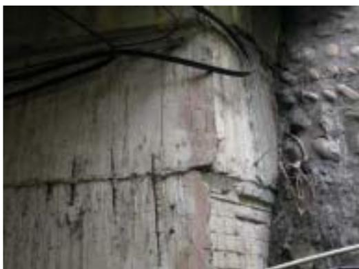
T2-27 橋台鋼筋腐蝕外露
