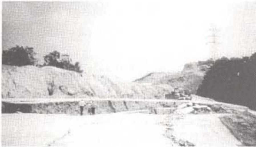
圖 1 路堤坍塌，填築路面有高差及裂縫產生
