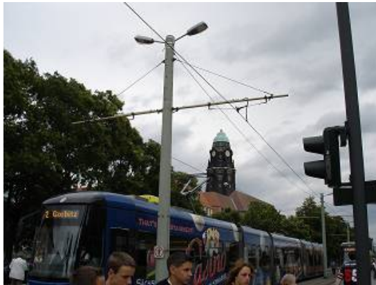
圖 4.1.21 德瑞斯登十字型架空線與豐橋市中央型式架空線
