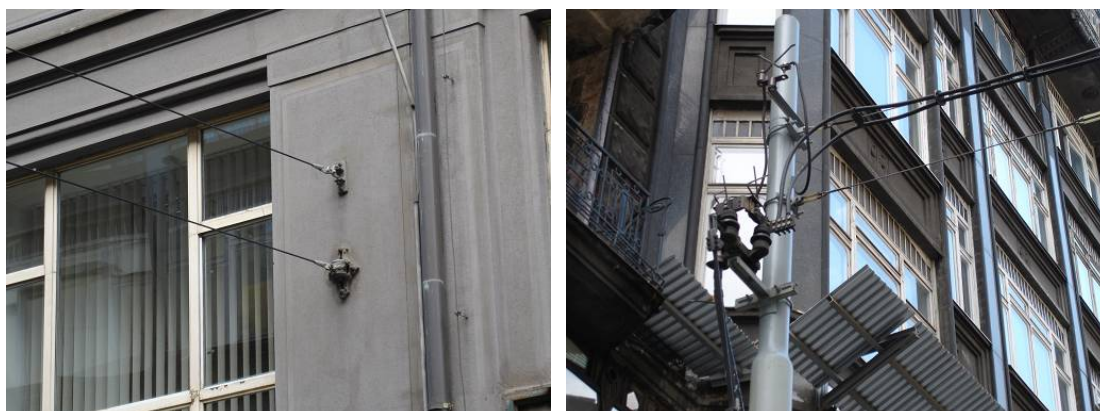
圖 4.1.20 布拉格架空線固定建物與架空線固定於電桿
