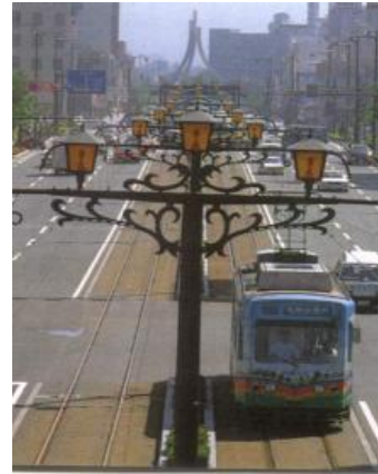
圖 4.1.21 德瑞斯登十字型架空線與豐橋市中央型式架空線
