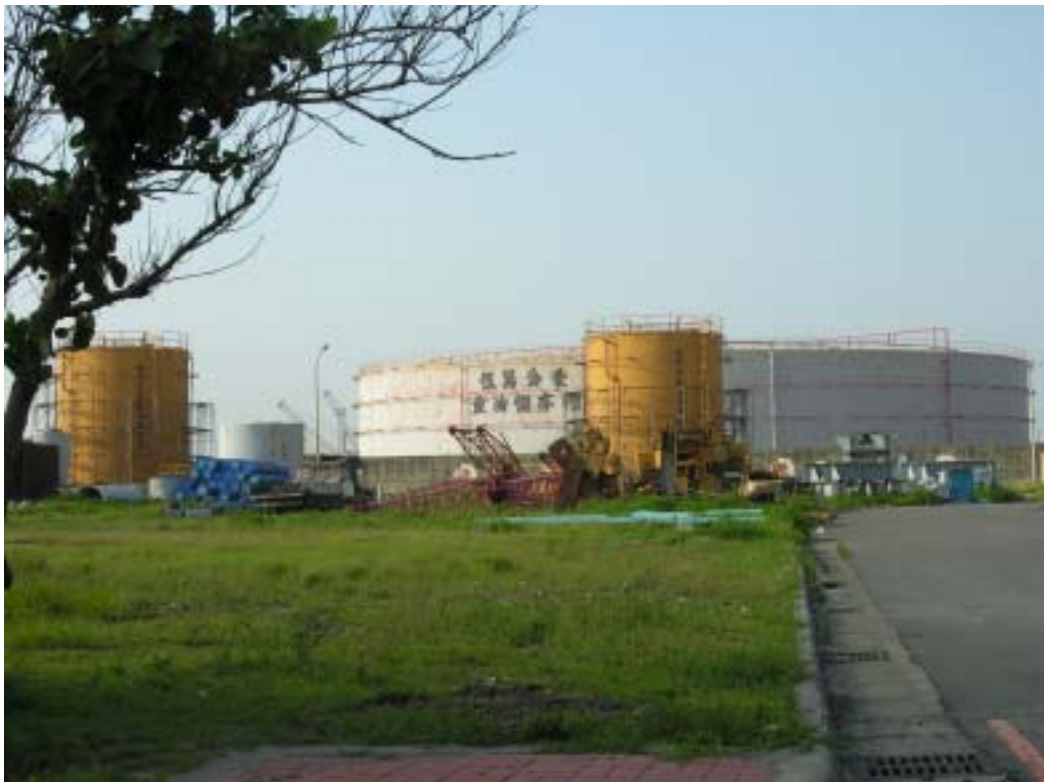
圖 3-4-5 電力專業區(I)內台電重油儲存槽現況照片
