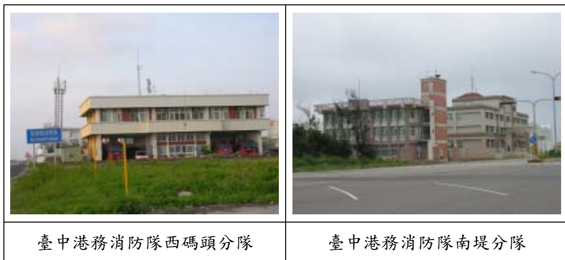
圖 3-2-5 臺中港務消防隊各分隊現地調查照片
