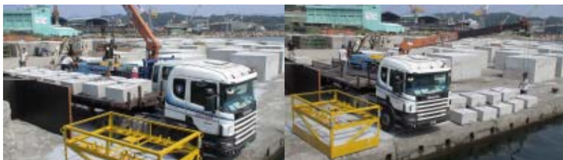
【2-1】 95 年 8 月 14 日將 16 顆水泥塊、1200 米錨練、儀器架及 1200 米水下電纜 ( 500mX2 + 200mX1 ), 載運至基隆港東堤處置放。
