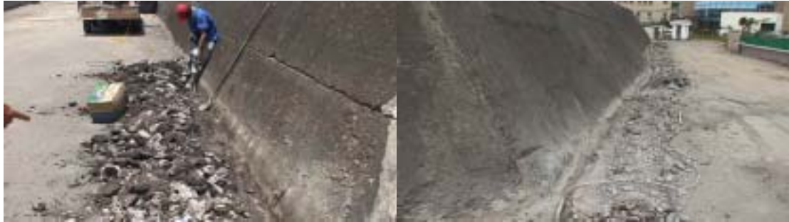
【1-1】 沿東防波堤盡頭處挖設纜線溝槽供電纜鋪設連接舊有線路至信號台
