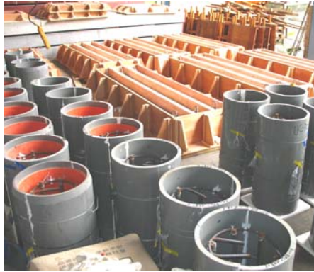
照片七 灌製前縮小尺寸梁及柱之模具
