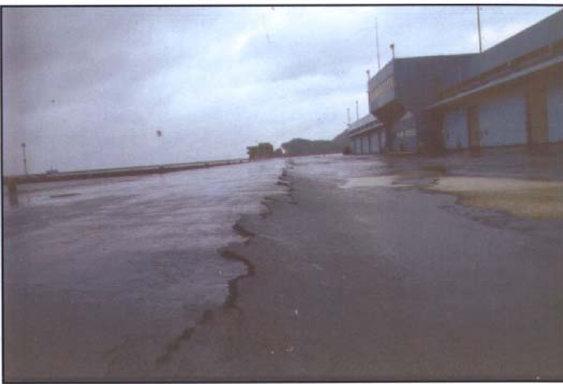
照片 民國75年地震造成蘇澳港3-5號碼頭後線下陷龜裂500公尺
