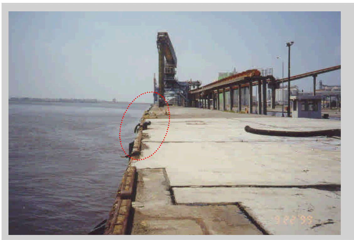
照片 3-4 民國 88 年 921 地震造成臺中港 3 號碼頭外移 1.7m
