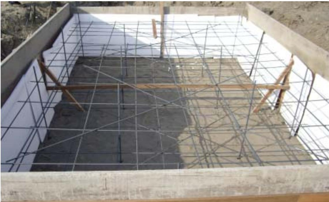
圖 7-4 震動基礎內鋼筋及保麗龍設置情形圖
