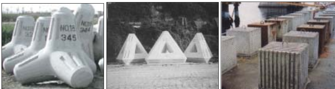
照片 2.2 表面凹凸處理之消波塊與方塊
