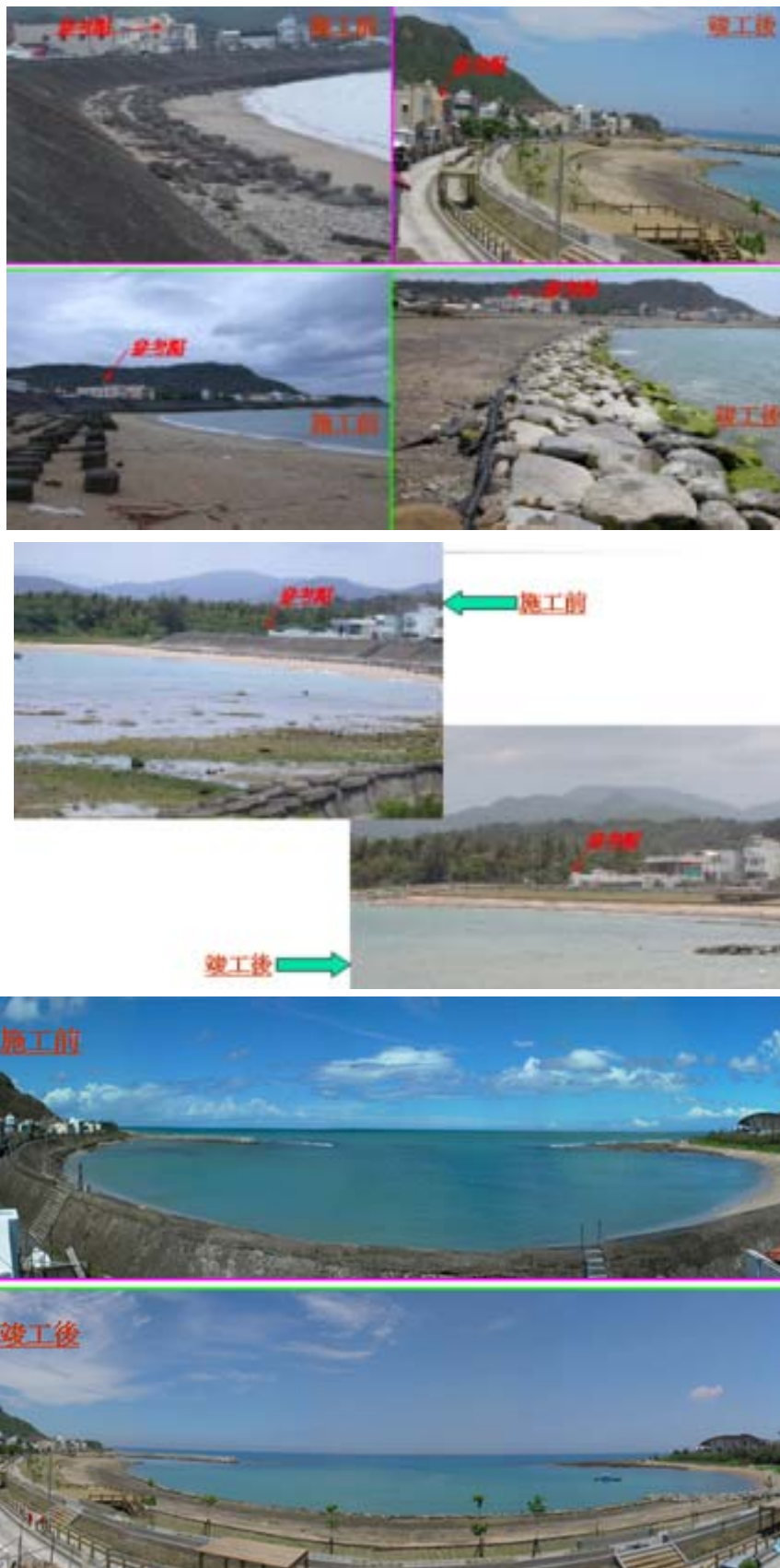
照片 2.4 後灣海岸環境及景觀改善工程施工前後( http://www.wra07.gov.tw )
