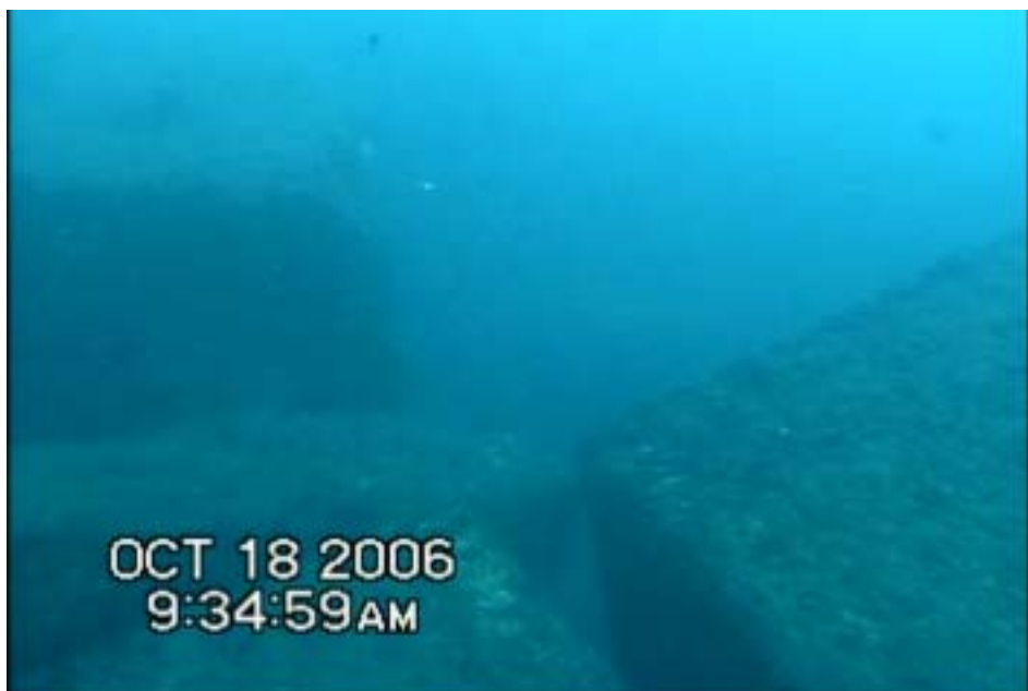
照片 5.1 花蓮港東防波堤#26 沉箱位移情況
