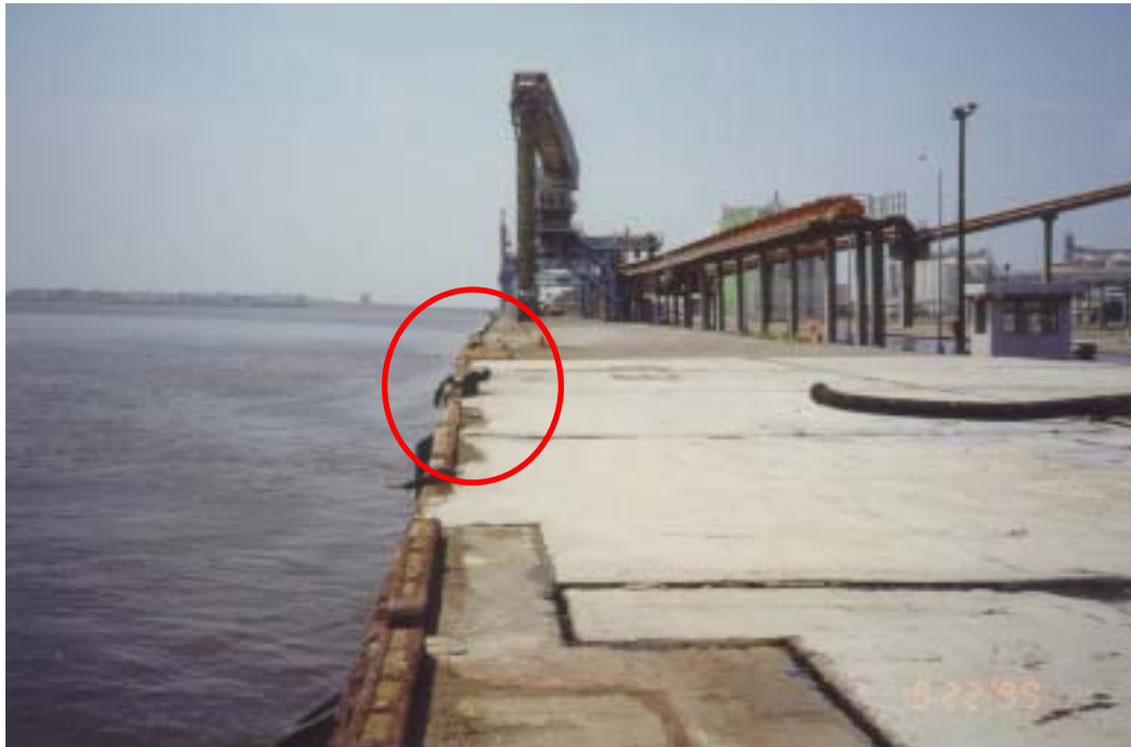
圖 3.1 #1~#4 沉箱式碼頭法線變位側視圖
