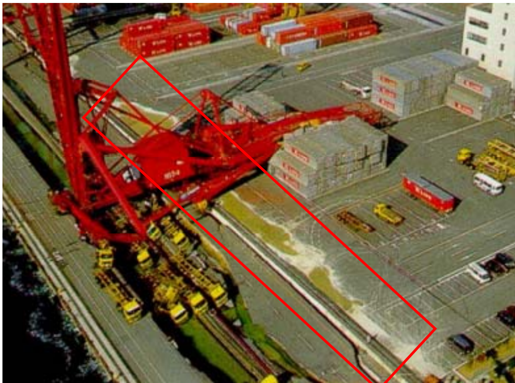
圖 3.8 日本阪神地震神戶港沉箱式碼頭災損情形
