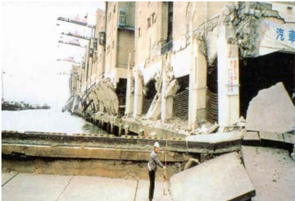
圖 3.10 日本阪神地震神戶港板樁式碼頭岸肩沉陷災損情形
