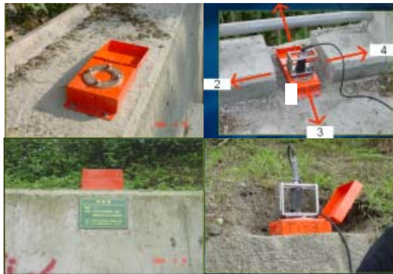
圖 10-11 傾度盤安裝於擋土結構上之方式
