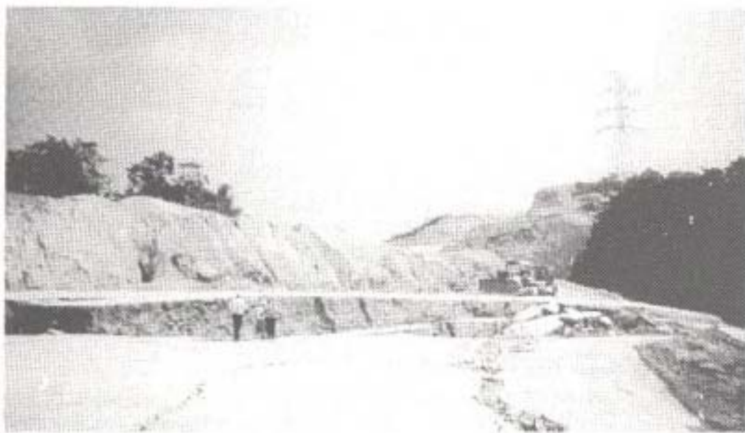
圖 6-1 路堤坍滑（大地工程困難案例，2003）
