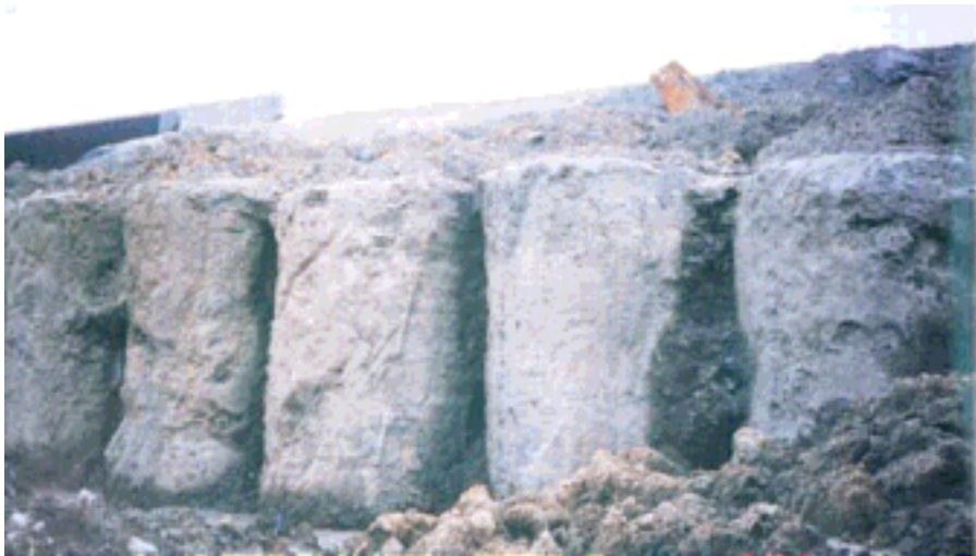
圖 11-34 路堤坡趾打設 PC 預鑄止滑樁及場鑄鑽掘排樁照片
