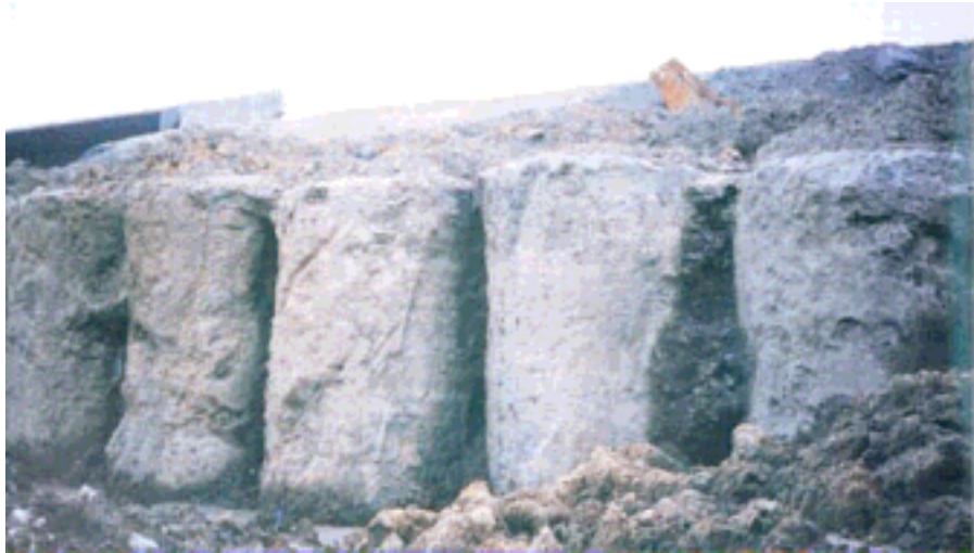
圖 10-23 路堤坡趾打設 PC 預鑄止滑樁及場鑄鑽掘排樁照片
