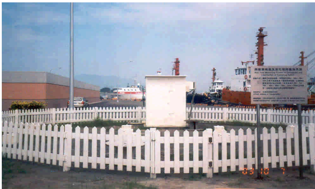
圖 2-8 高雄港地震監測站照片
