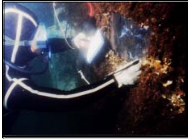
圖 2.2 水面下超音波量測鋼板樁厚度之情形
