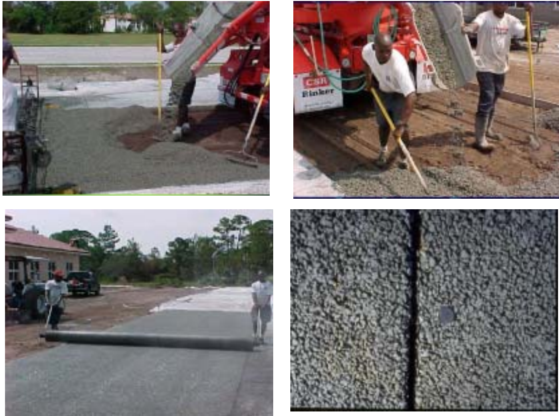
圖 5.59 透水混凝土之施工過程 [44]
