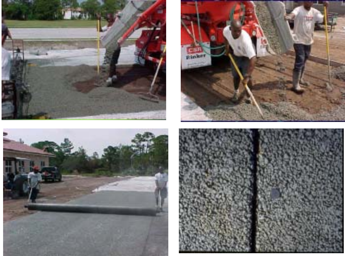
圖 5.59 透水混凝土之施工過程 [48]
