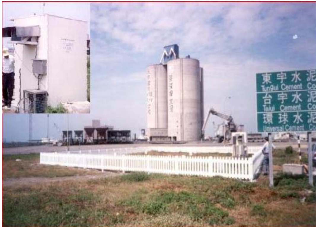
圖 12-9 臺中港區地震分層監測站設置完成外貌狀況
