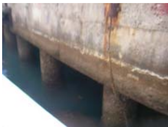
(4) 1 號碼頭第 7 單元電位測試裝置生銹
