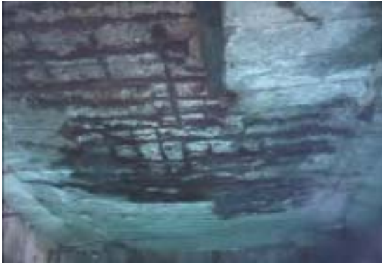
(3) 面版與樁頭交接處鋼筋外露 3
