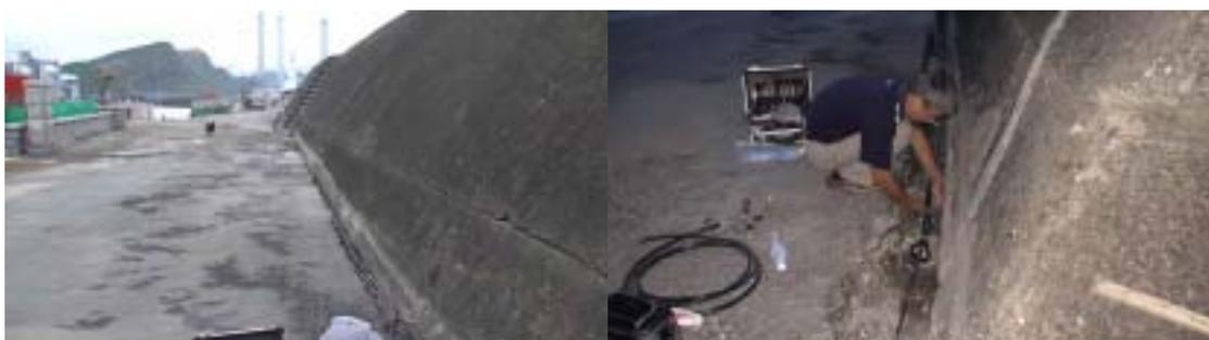
【1-3】 纜線鋪設銜接完成後進行水泥灌漿作業
