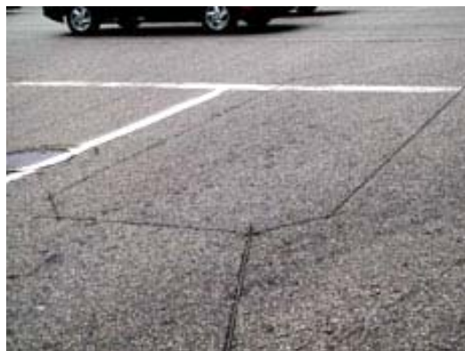
圖 3.3.1-2 單迴圈偵測器實際佈設情形 2
