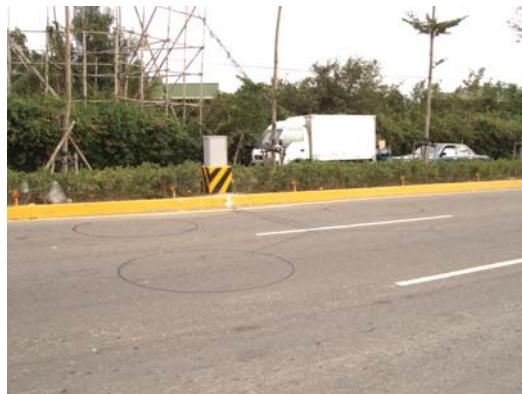
圖 3.3.1-1 單迴圈偵測器實際佈設情形 1
