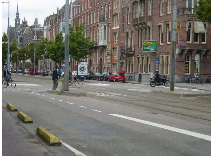
圖 4.1.9 荷蘭阿姆斯特丹以微凹的坡面將軌道與車道隔離(1)
