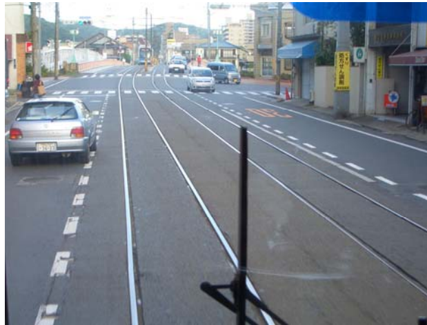
圖 6.3.7 標線分隔（日本岡山電鐵）
