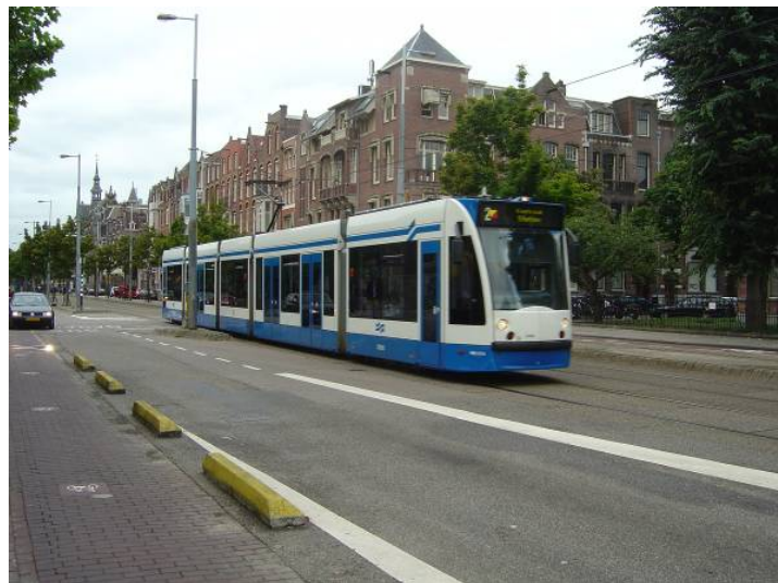
圖 4.1.10 荷蘭阿姆斯特丹以微凹的坡面將軌道與車道隔離(2)
