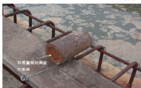
照片 3-5 聯結器拆卸照片(二)
