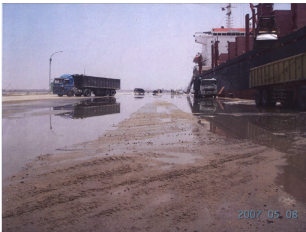
照片 4-1 東 14 號碼頭基地嚴重積水泥濘不堪 (中華顧問工程司提供)
