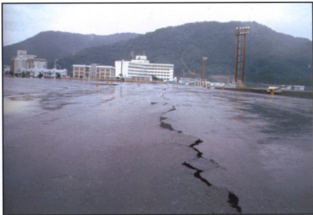
照片 3-2 民國 75 年地震造成蘇澳港 4-5 號碼頭後線下陷龜裂 500 公尺(溫國樑教授提供)
