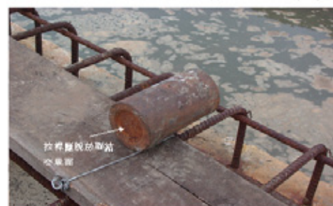
照片 3-5 聯結器拆卸照片(二)
