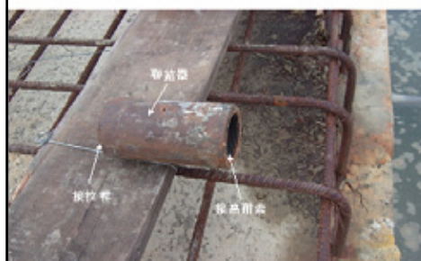
照片 3-4 聯結器拆卸照片(一)
