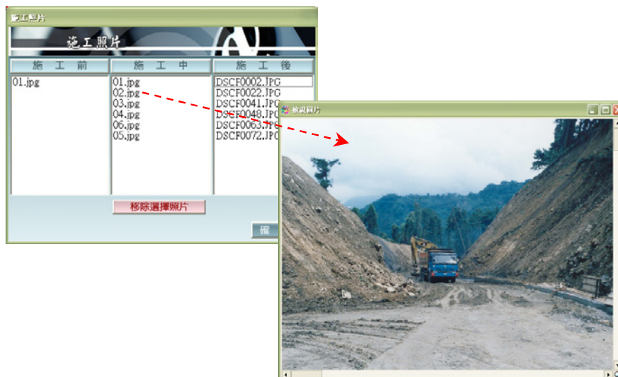
圖 2-17 工程資料庫中之施工照片填報界面[1]
