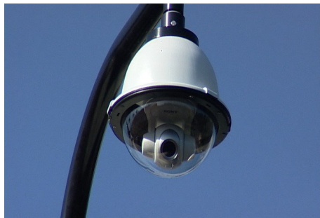
圖 3-4-4 攝影機吊架與室外保護罩
