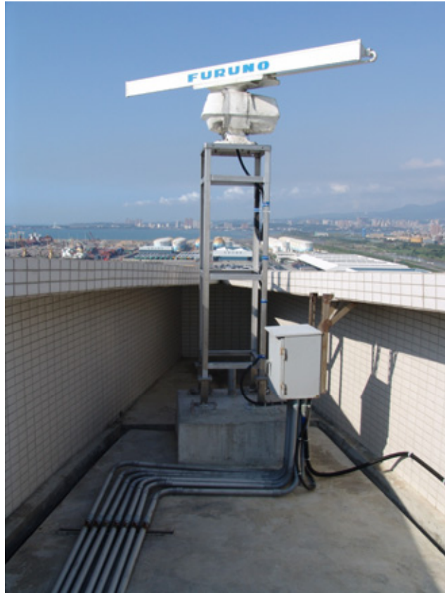
圖 5-11 雷達測波儀
