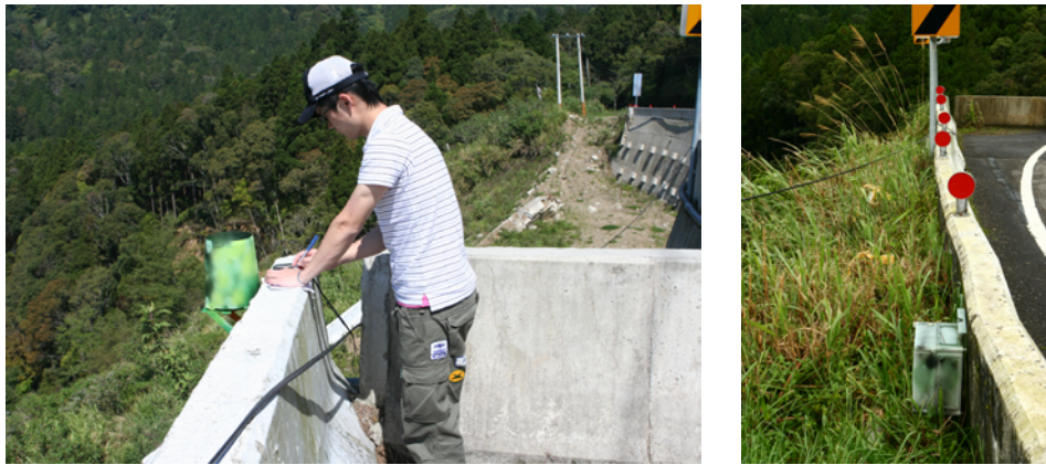
圖 5-14 R-T18-82K+300 雨量站安裝情形
