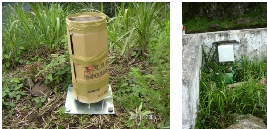
圖 5-12 R-T18-69K+900 雨量站安裝情形
