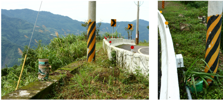
圖 5-13 R-T18-78K+600 雨量站安裝情形
