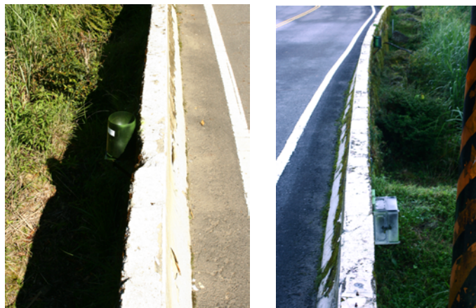
圖 5-15 R-T18-90K+200 雨量站安裝情形
