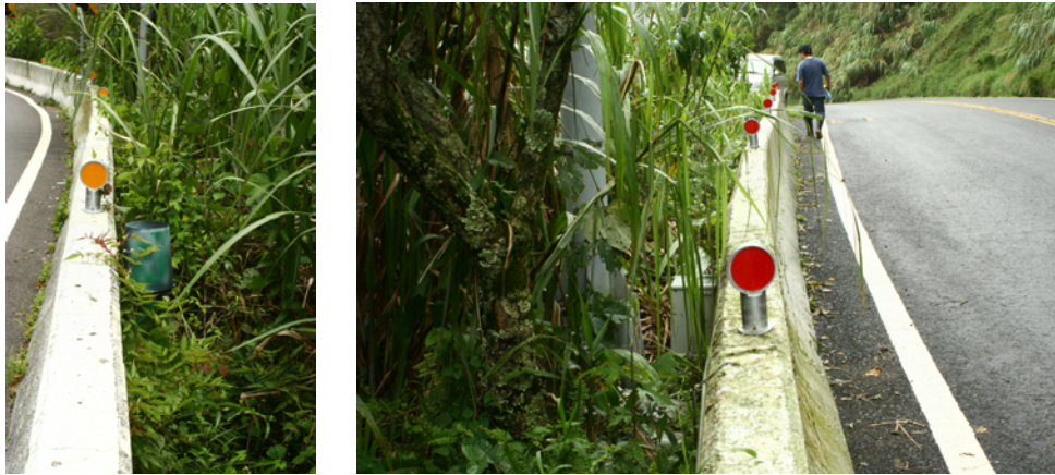
圖 5-11 R-T18-54K+100 雨量站安裝情形
