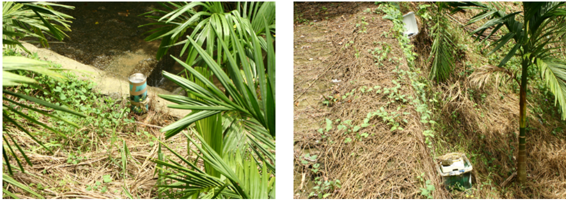
圖 5-10 R-T18-41K+700 雨量站安裝情形
