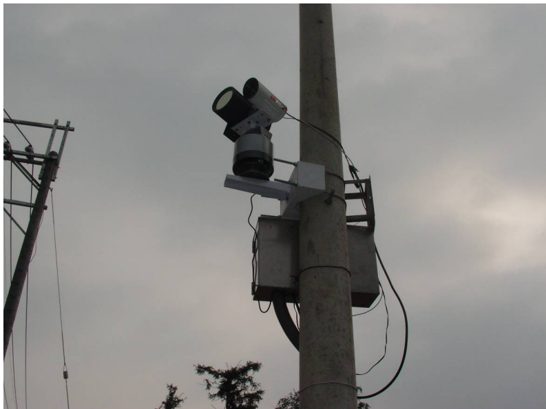
圖 3-25 臺 18 線 45K CCD 攝影機及紅外線投射燈
