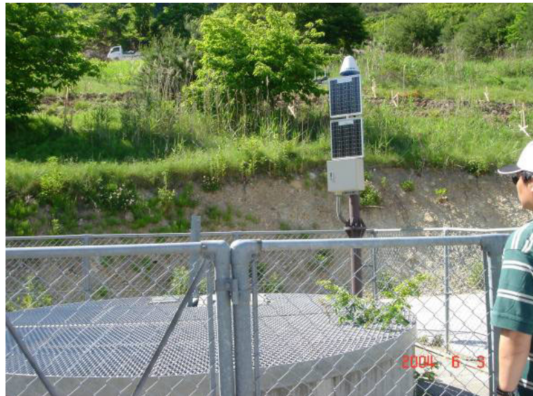
圖 1-12 長野縣集水井
