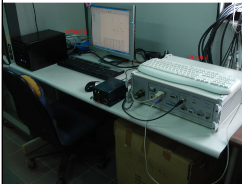
室內儀器設備
