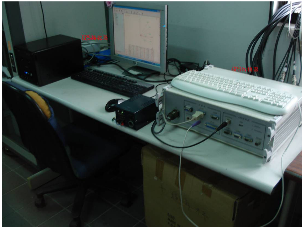
圖 3-9 多天線 GPS 試驗設備
