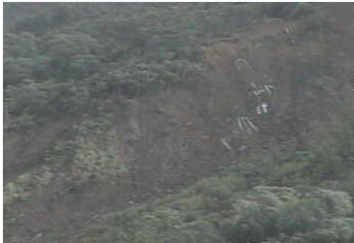
圖 3-31 小公田村 CCD#2 傳回之崩塌區影像
