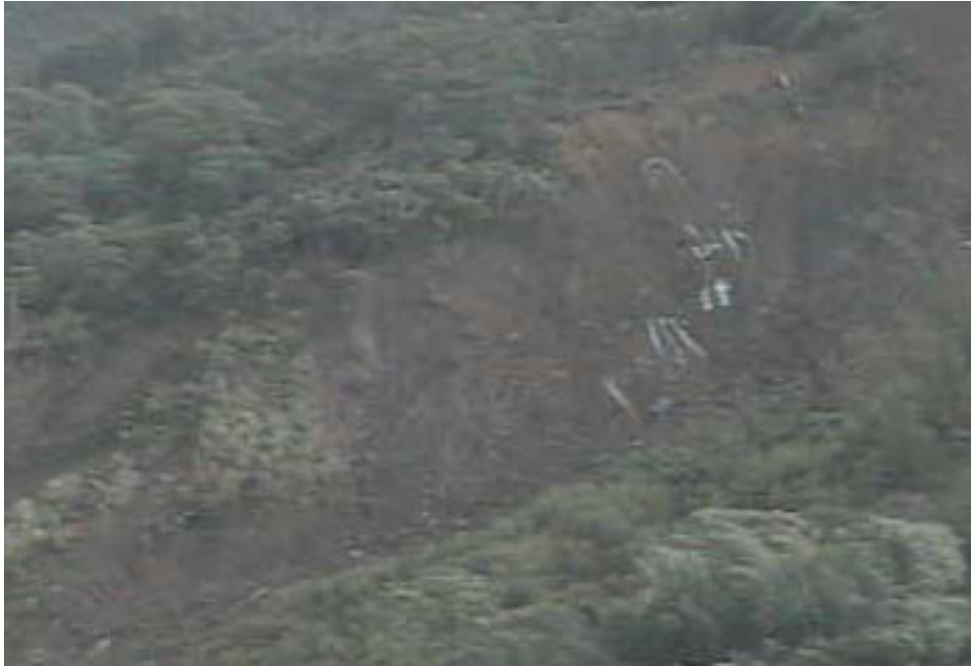
圖 2-7 小公田村 CCD#2 傳回之崩塌區影像
