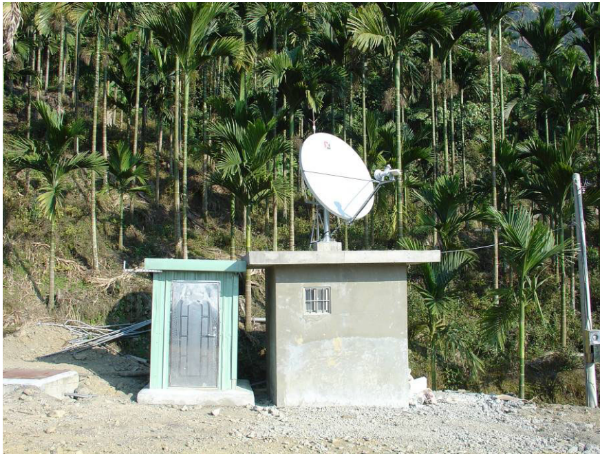
圖 2-1 臺 18 線 45K 自動化監測儀器小屋
