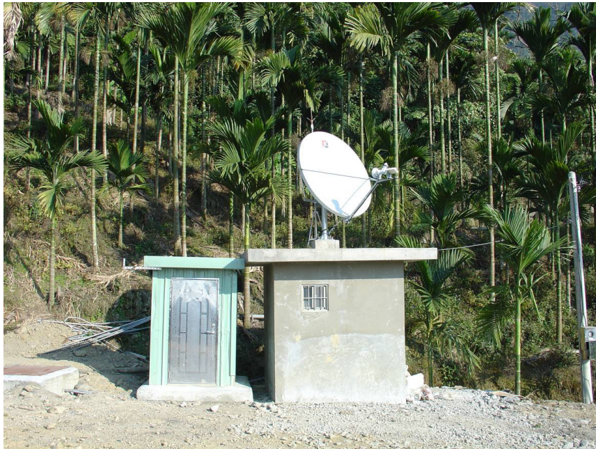
圖 3-24 臺 18 線 45K 自動化監測儀器小屋
