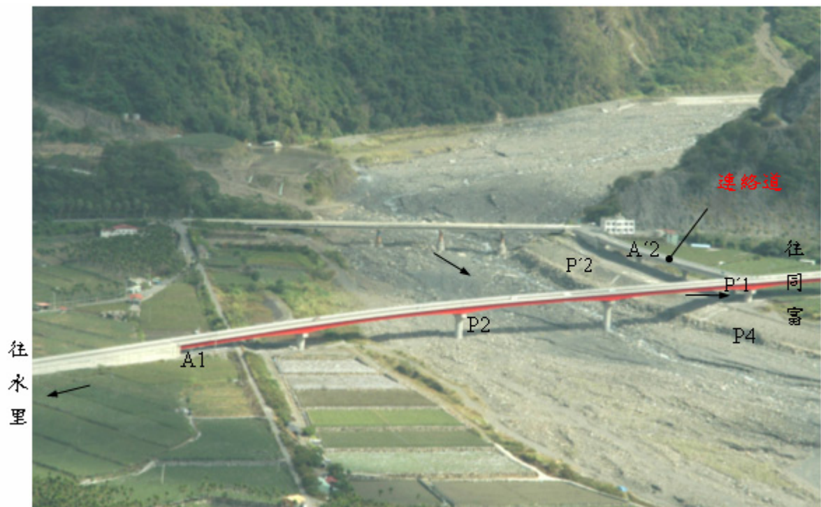
圖 4-53 陳有蘭溪橋復建工程完工情況
