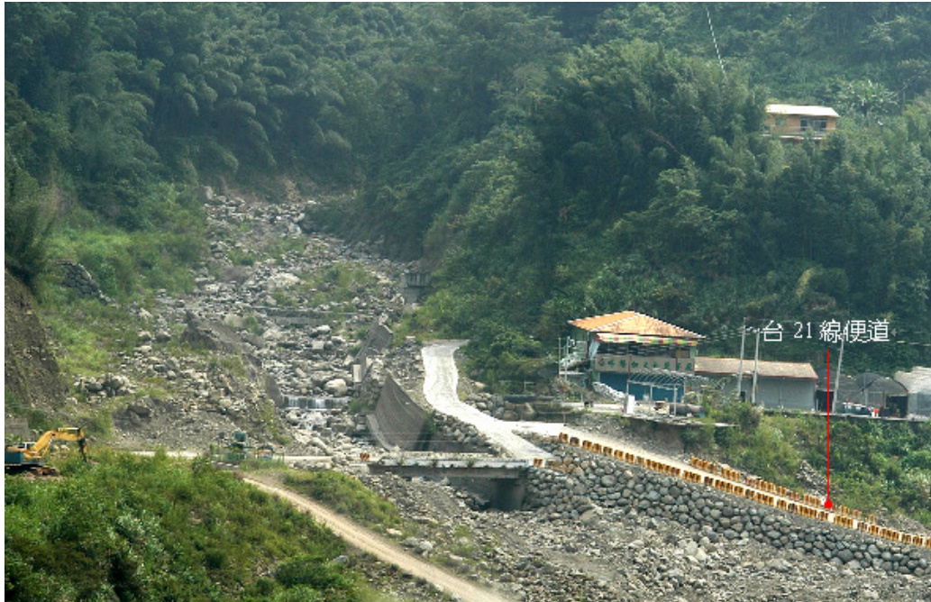
圖 4-72 愛玉橋上游野溪在歷經民多次颱風後河道土石堆積之情況
