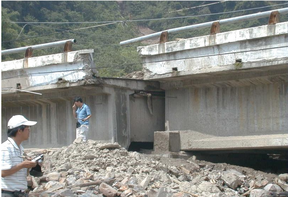
圖 4-36 十八重溪橋上部結構遭推移達兩公尺之情形
