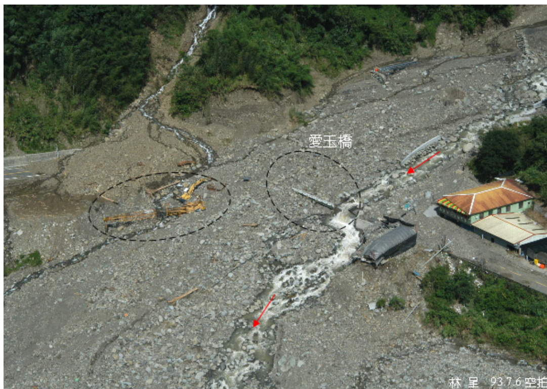
圖 4-70 敏督利颱風後愛玉橋遭土石流淤塞及施工機具遭掩埋之情況
