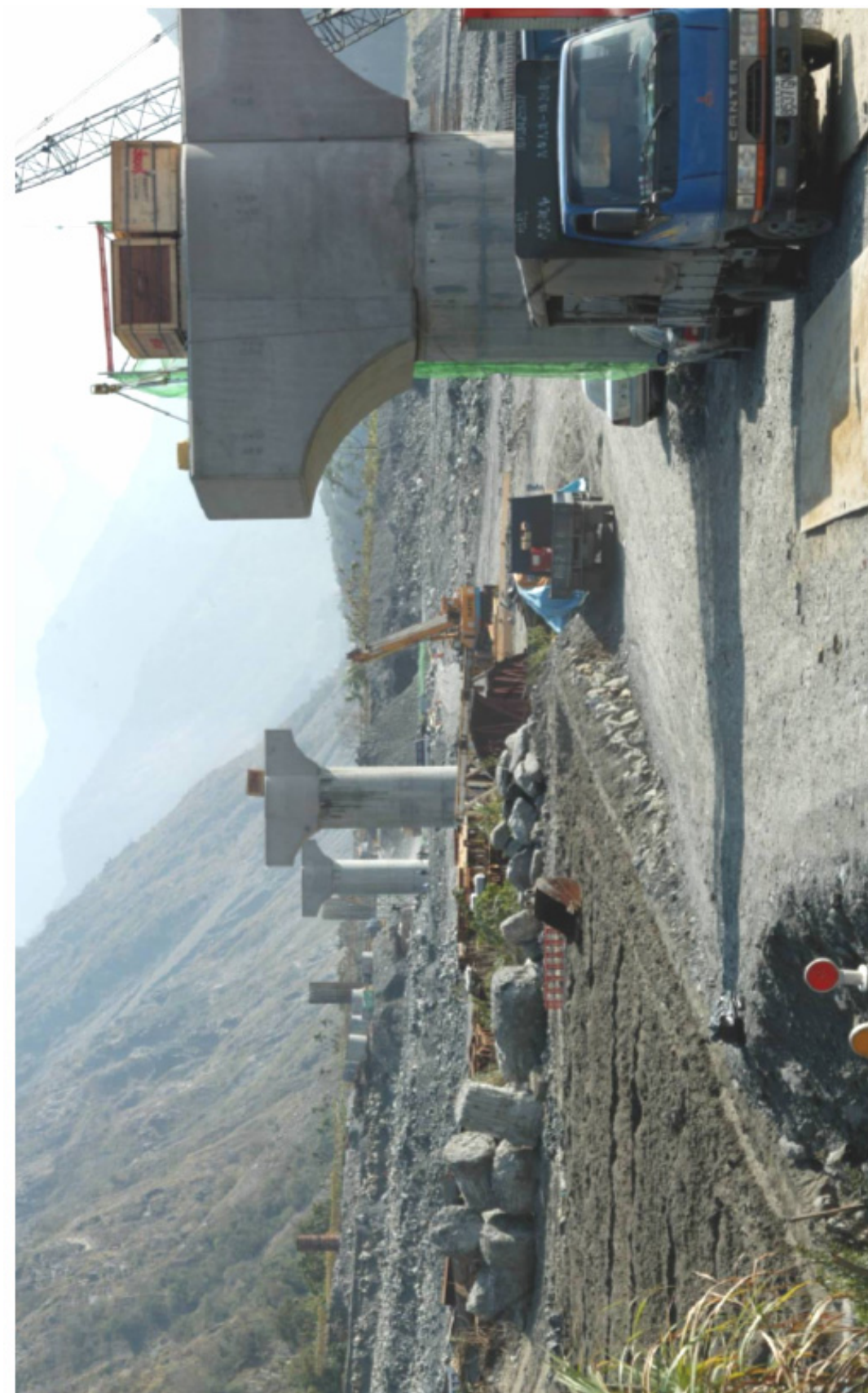
圖 4-48 陳有蘭溪橋復建工程北段墩柱施工完成情形
