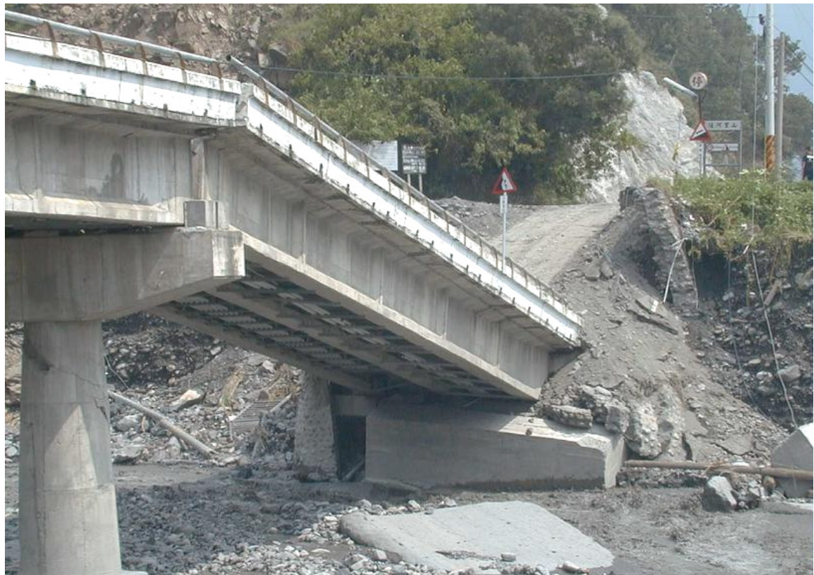
圖 4-41 桃芝颱風過後十八重溪橋南端橋面崩落情形
