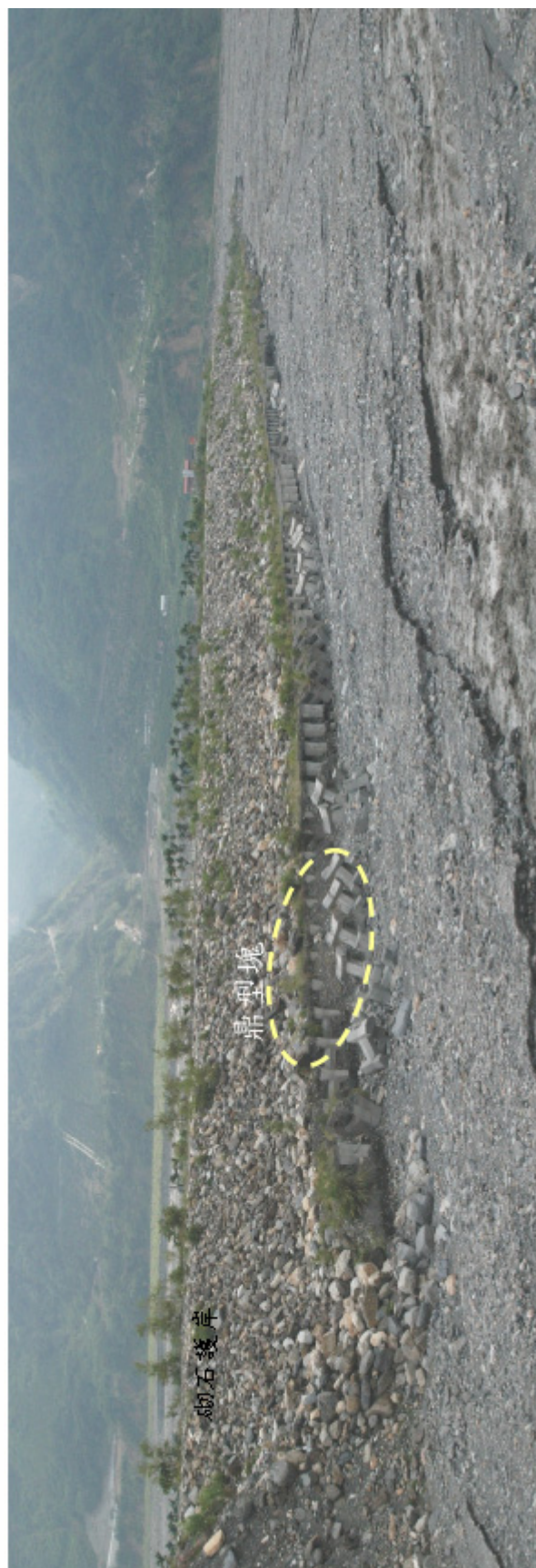
圖 4-29 敏督利颱風過境，上、下游側左岸設置頂型塊及砌石護岸之情形
