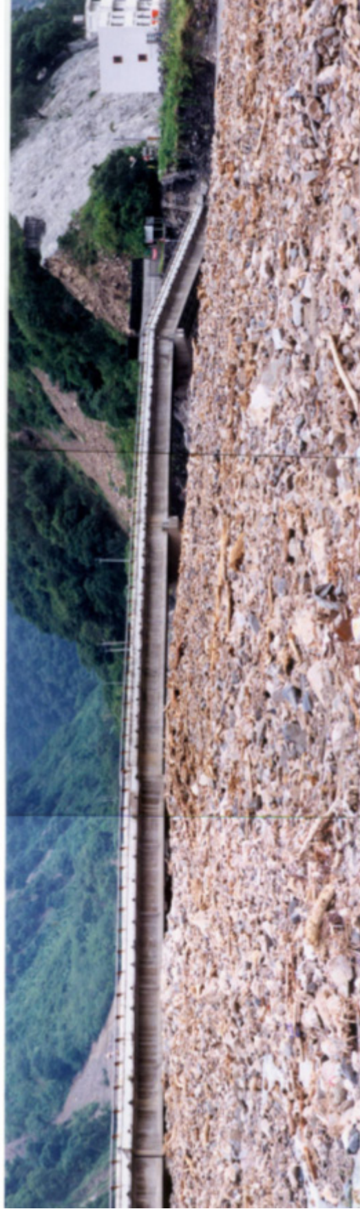
圖 4-37 桃芝颱風後十八重溪橋梁 A2 橋台及護岸沖刷破壞情形
