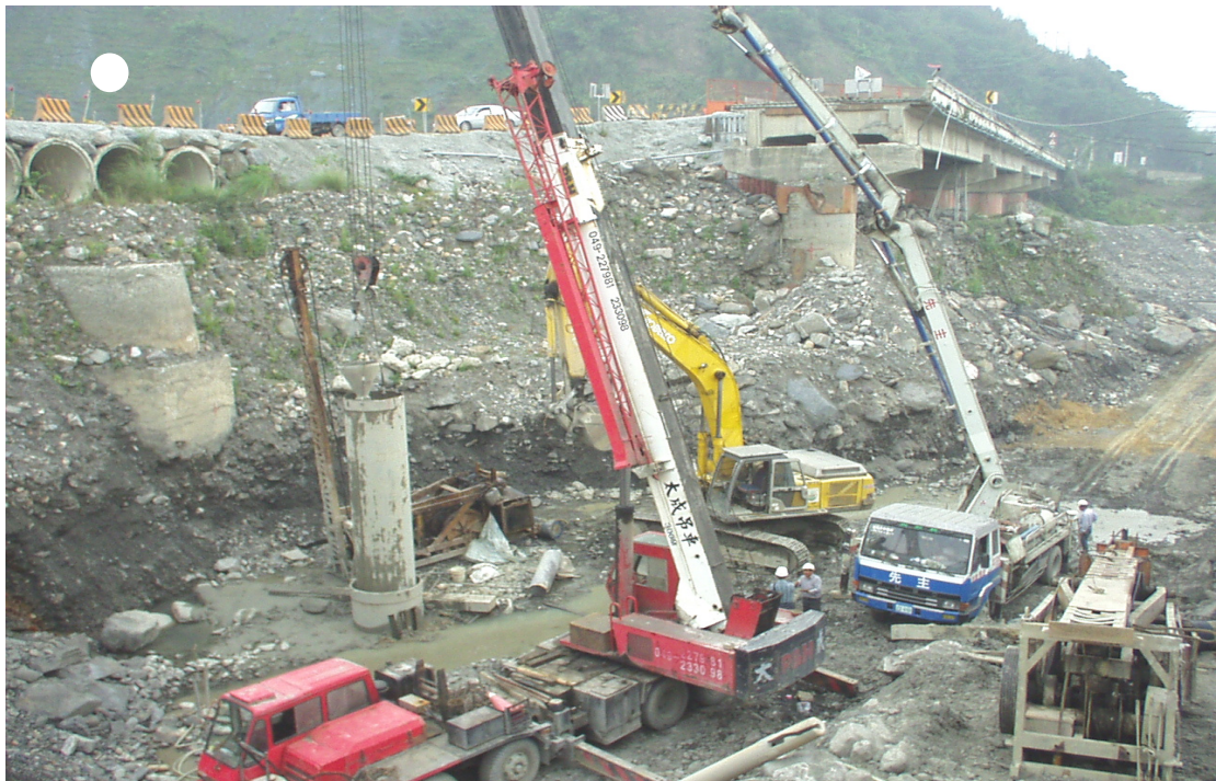
圖 4-17 復建之 P1 全套管基樁施工
