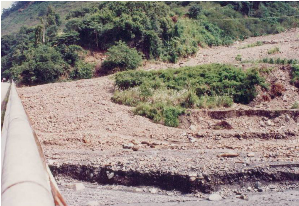
圖 4-32 賀伯颱風期間十八重溪橋北端橋孔遭土石淤埋情形
