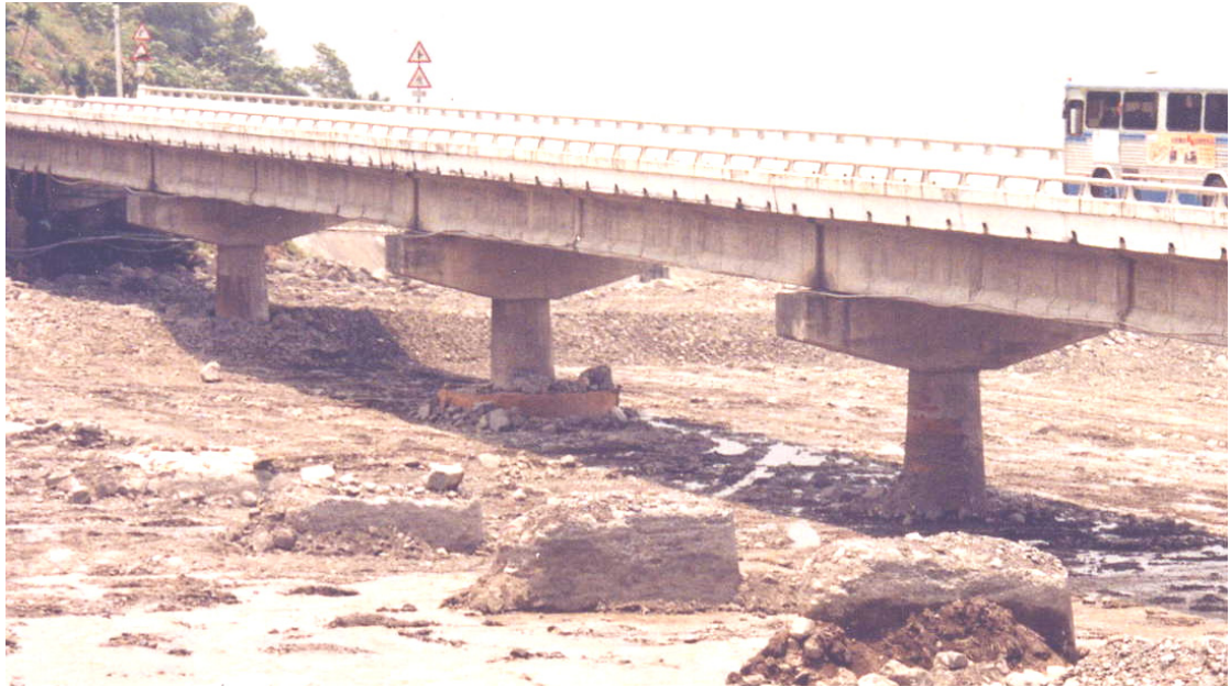
圖 4-10 賀伯颱風過後，信義橋進行 P4 橋墩包墩補強
