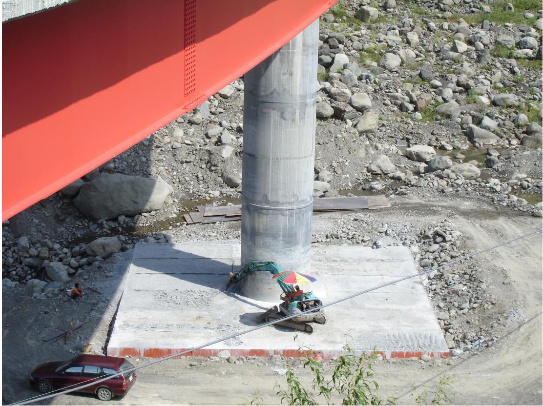
圖 4-87 愛玉橋 P2 橋墩基礎補強情形(攝於 96.10.04)
