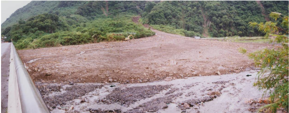
圖 4-34 碧利斯颱風過境，上游土石流沖積扇堆積情形
