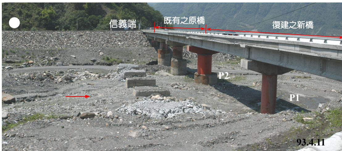
圖 4-19 信義橋復建完成後通車之情形
