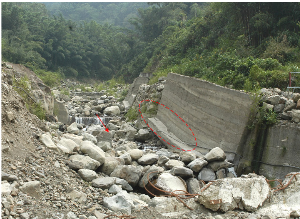
圖 4-73 愛玉橋上游野溪左岸護岸基腳已被淘空(圈示處)
