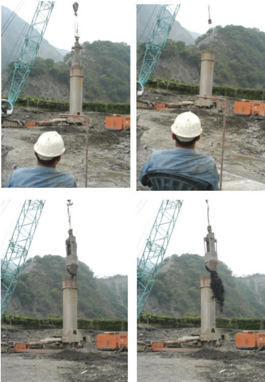
圖 4-47 陳有蘭溪橋復建工程北段 P4 全套管樁基礎施工過程
