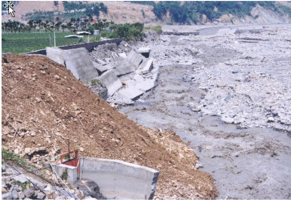
圖 4-9 桃芝颱風期間，下游側堤防址部遭沖刷淘空情況
