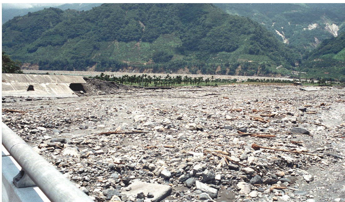
圖 4-8 賀伯颱風期間，洪水土石沖刷毀損兩岸堤防
