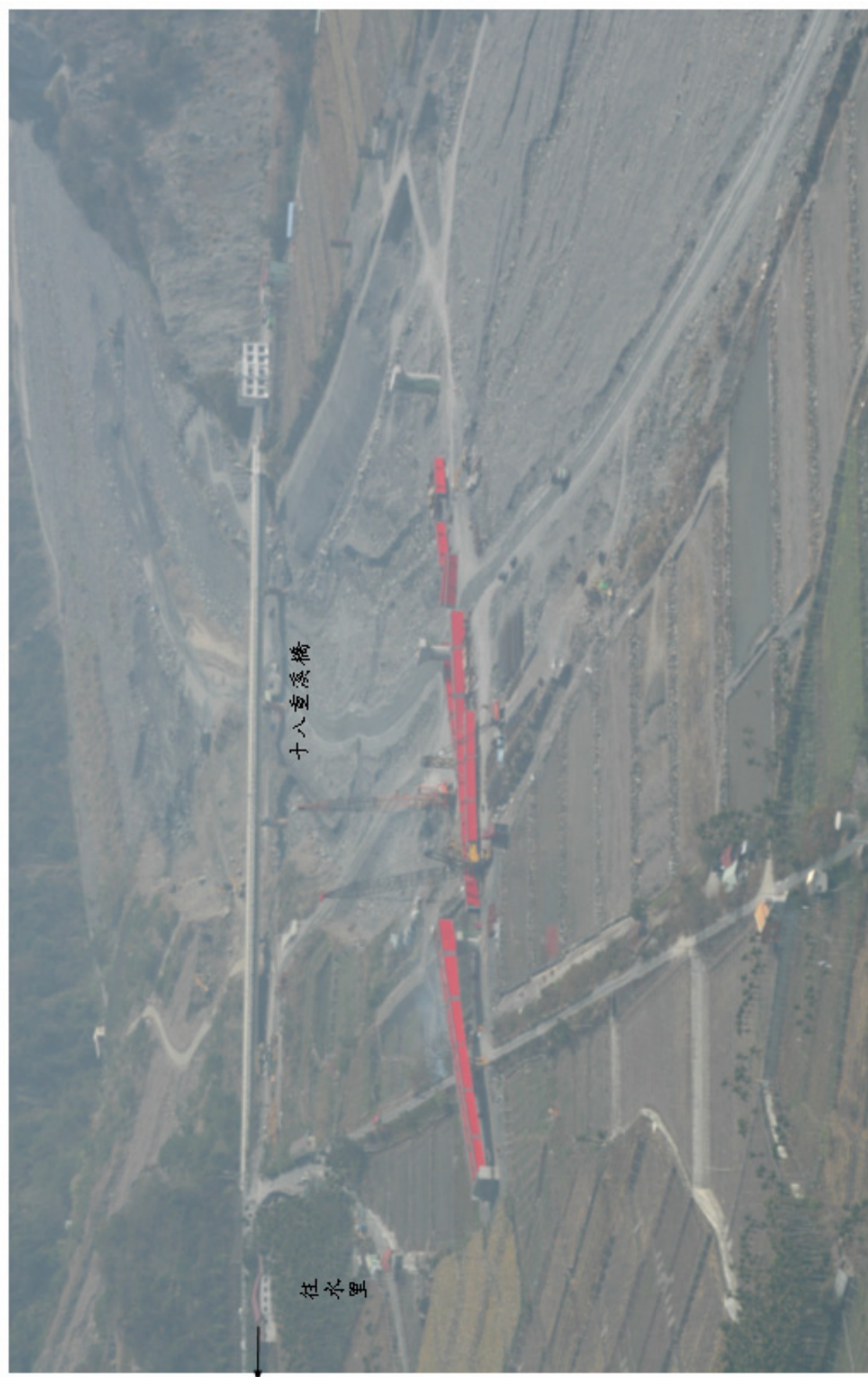
圖 4-49 陳有蘭溪橋復建工程北段鋼箱型梁分段組裝情形
