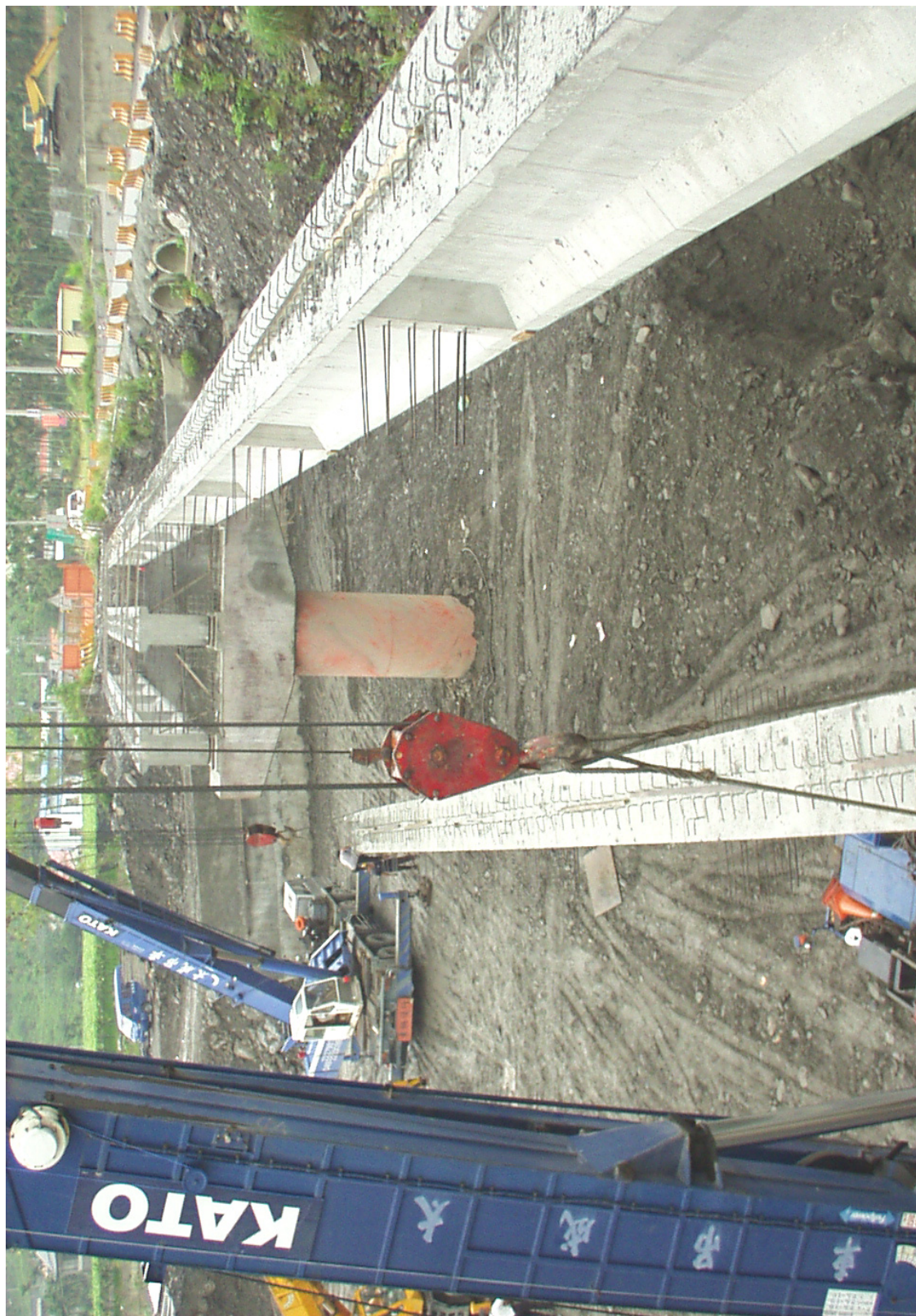
圖 4-18 預力梁施作及完成後吊裝之過程
