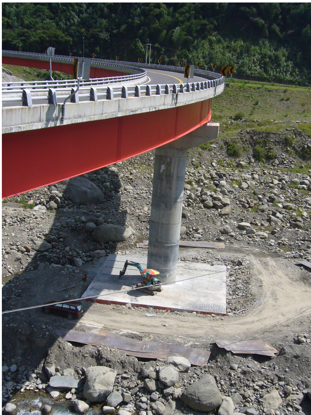
圖 4-86 愛玉橋復建工程完工後現況(攝於 96.10.04)
