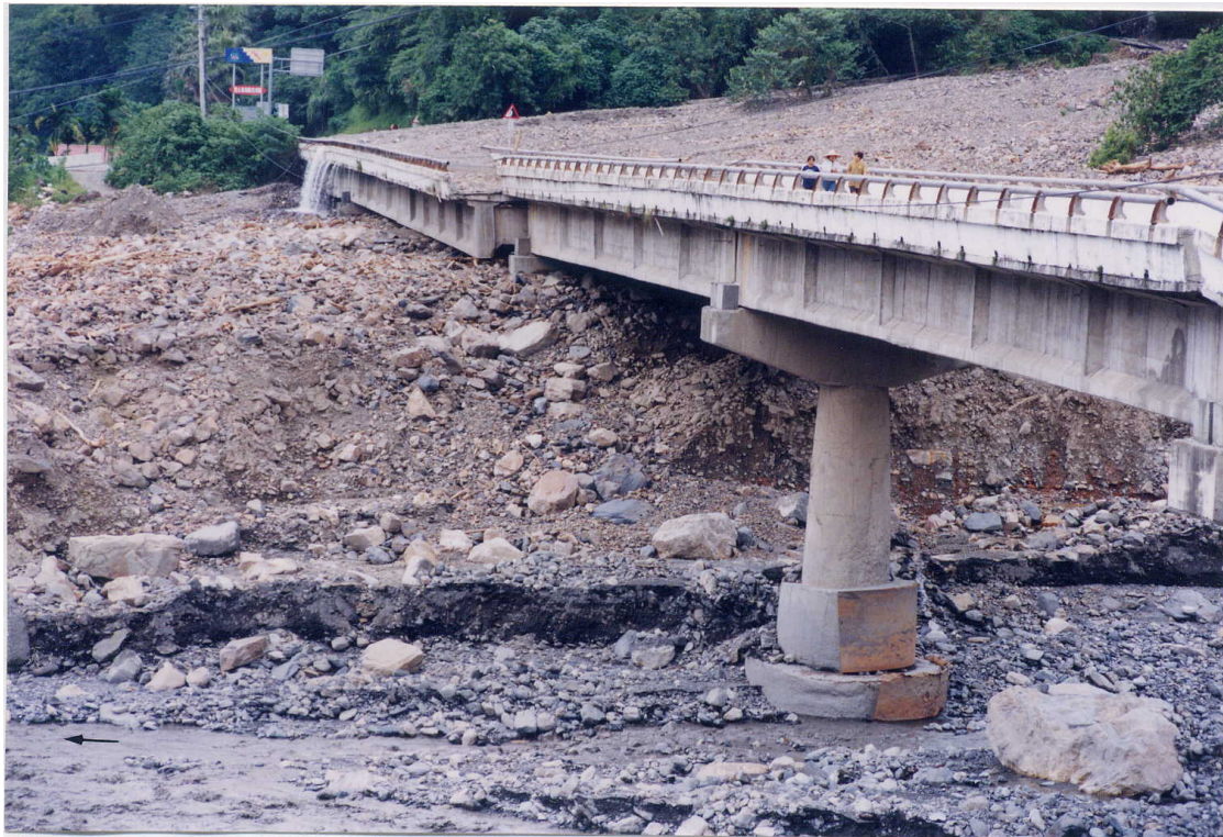
圖 4-35 桃芝颱風過後十八重溪橋 A1 橋台錯位破壞
