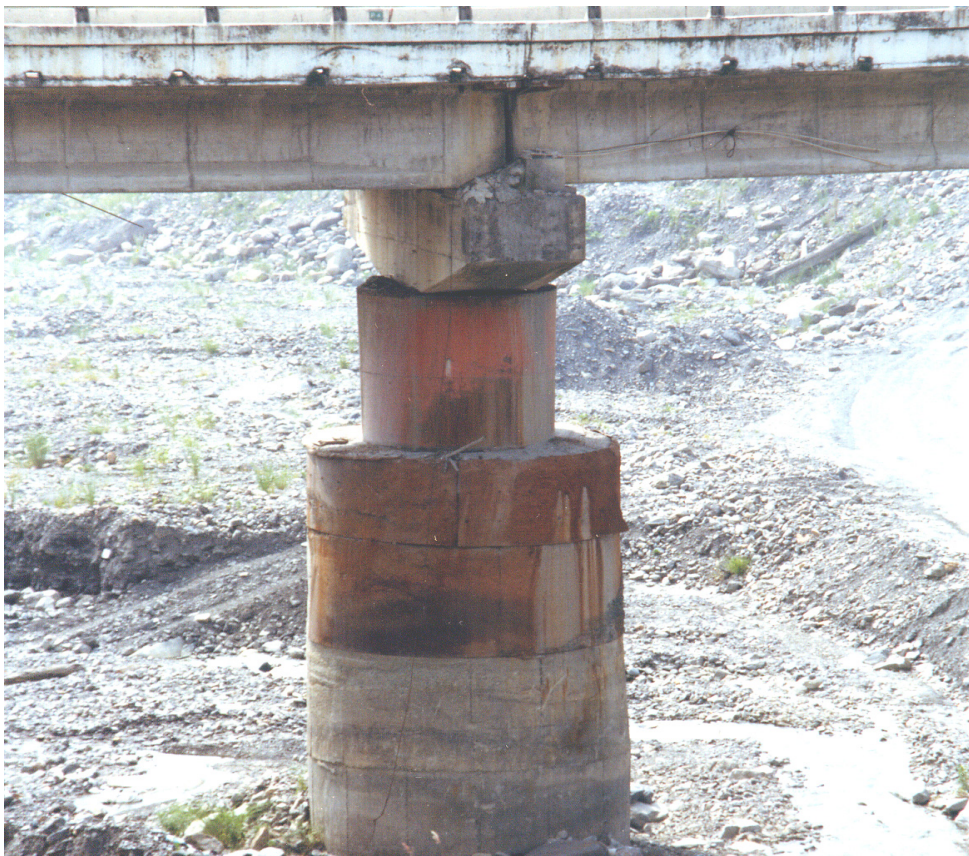
圖 4-11 民國 89 年 921 地震過後，信義橋再度進行包墩補強作業
