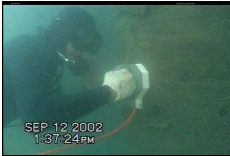
圖 2.5 海水中渦電流量測鋼板樁厚度之情形
